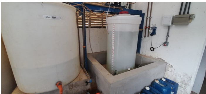
FOTO 14 NÃO CONFORMIDADE Sistema de contenção de vazamento
