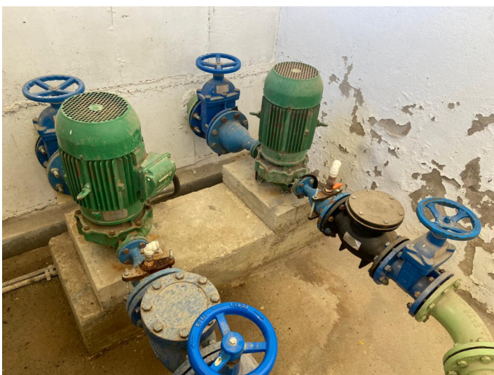
FOTO 10 NÃO CONFORMIDADE Pontos de descascamento de pintura
