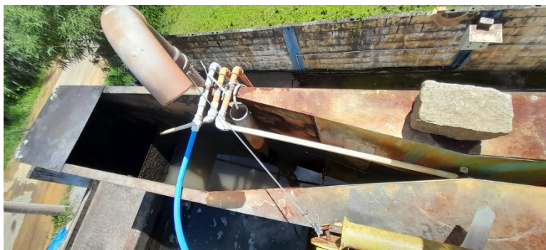
FOTO 7 NÃO CONFORMIDADE Sem marcação de vazão e uma pedra solta com risco de acidente
