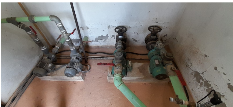
FOTO 3 NÃO CONFORMIDADE Paredes com descascamento
