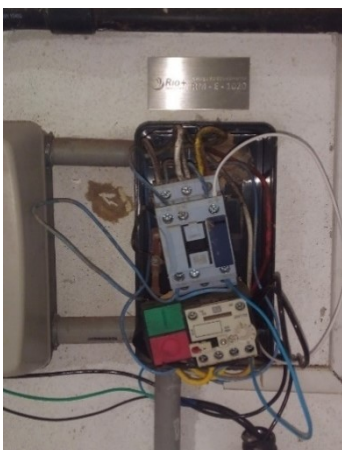
FOTO 4 NÃO CONFORMIDADE Má instalação
