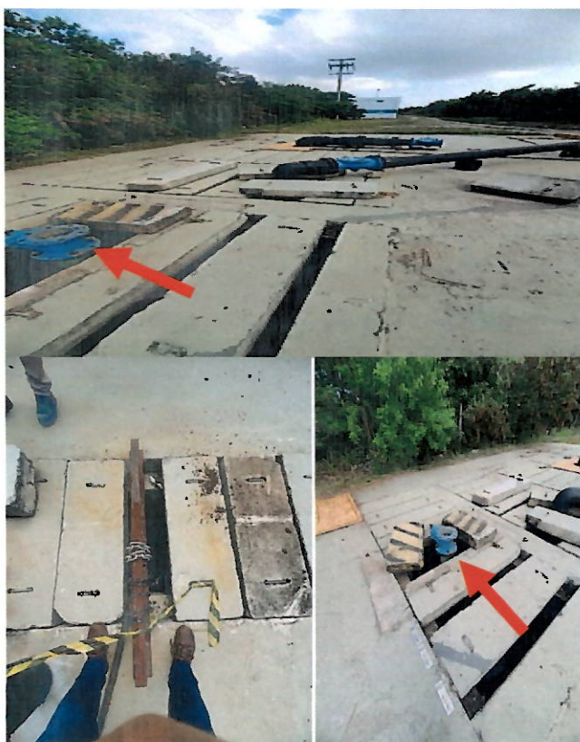
NÃO CONFORMIDADE FOTO 4 Abertura nas tampas dos poços e ao redor das tubulações.
