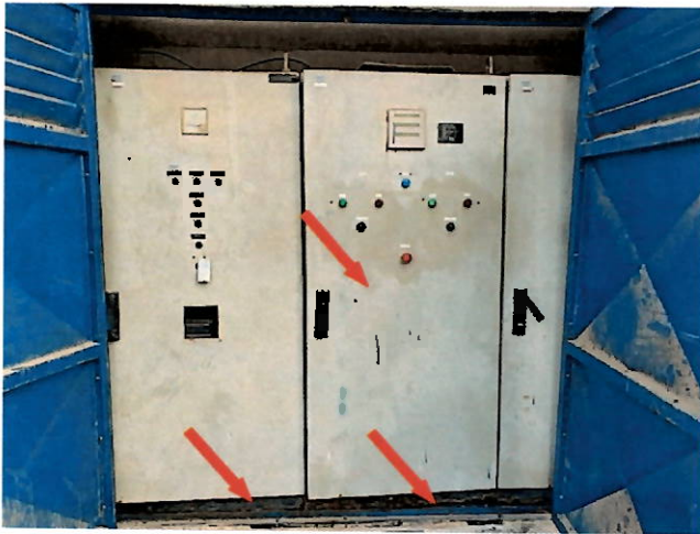
FOTO 5 NÃO CONFORMIDADE Sistema elétrico com estado inadequado de conservação.
