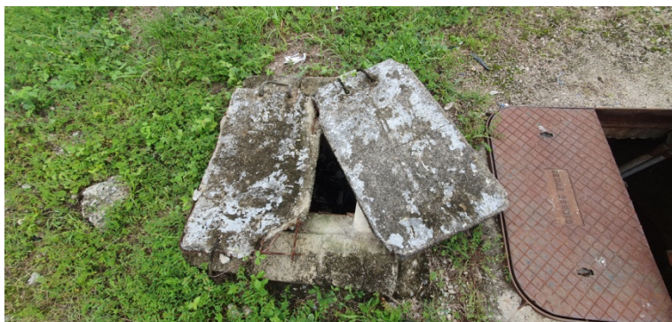
FOTO 8 NÃO CONFORMIDADE Tampa de proteção quebrada e cabos elétricos “embolados”
