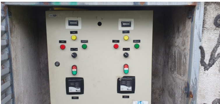
FOTO 6 NÃO CONFORMIDADE Não observada
