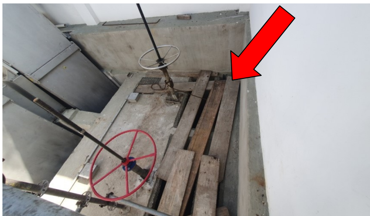
FOTO 5 NÃO CONFORMIDADE Ripas de madeira colocadas para “tapar” aberturas de manutenção nas comportas.
