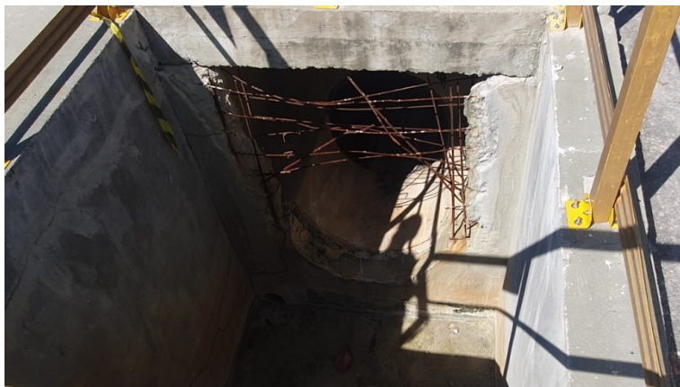
FOTO 5 NÃO CONFORMIDADE Ripas de madeira colocadas para “tapar” aberturas de manutenção nas comportas.
