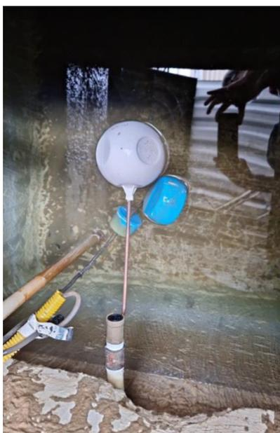
Cisterna com bóia branca (mecânica) trocada após o vazamento. A bóia azul aciona a bomba para enchimento da caixa d'água superior. Válvula de bóia fechada resulta hidrômetro parado.
