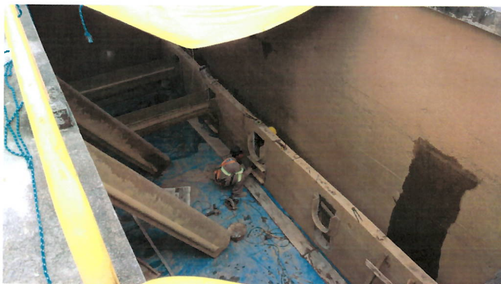
FOTO 3 - Processo de elevação das calhas dos filtros existentes
