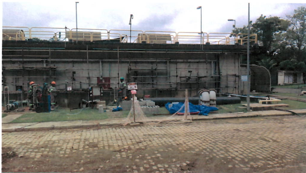
FOTO 2 - Retrofit sistema de lavagem filtros existentes
