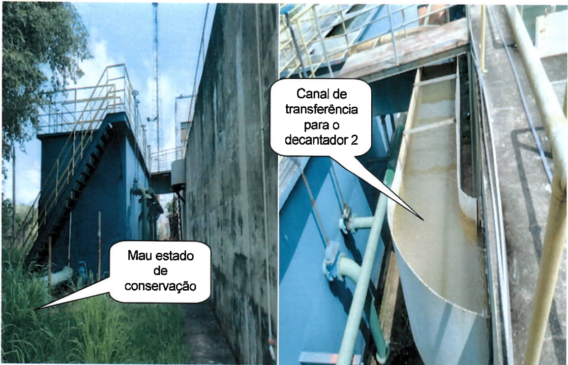
Canal de transferência do floculador
