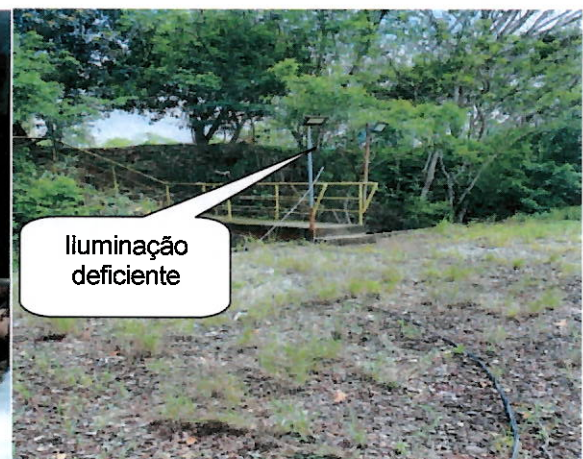
Passarela de acesso ao reservatório
