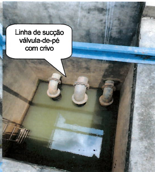
Poço de captação
