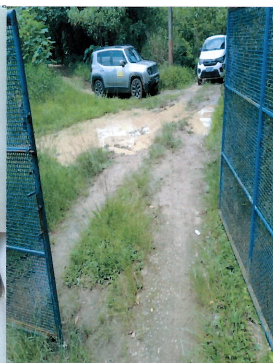
Acesso à EEAB em más condições
