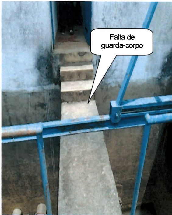
Passarela de acesso poço de captação
