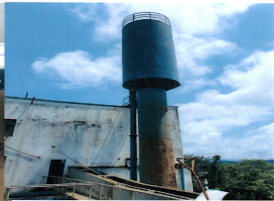
Reservatório para lavagem de filtro
