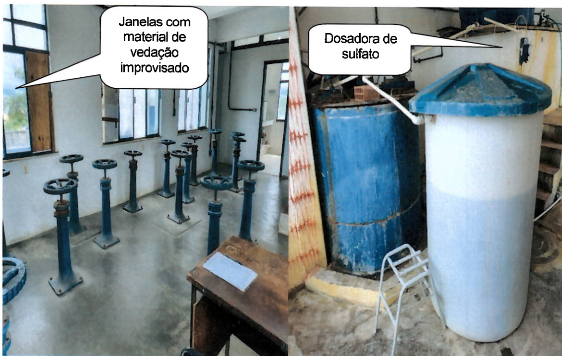
Sala de manobra de registros dos filtros
