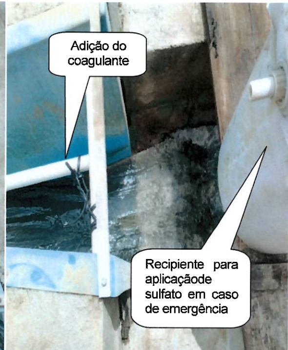
Saída da Calha Parshall
