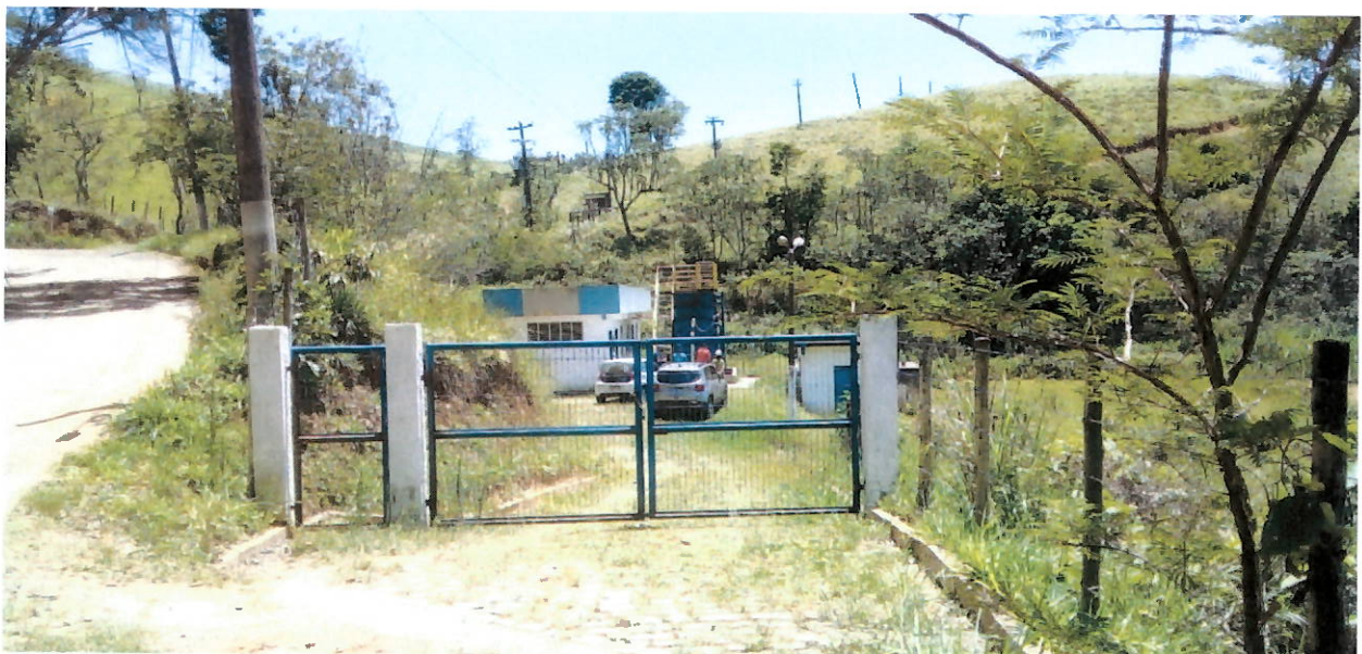
Vista frontal da entrada da ETA São Sebastião dos Ferreiros
