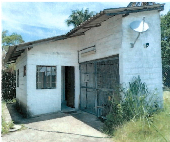
Prédio Administrativo necessitando de reforma e pintura; com uma sala para os Paineis elétricos, uma sala de depositos para EPIs, sala dos Operadores e um banheiro.
