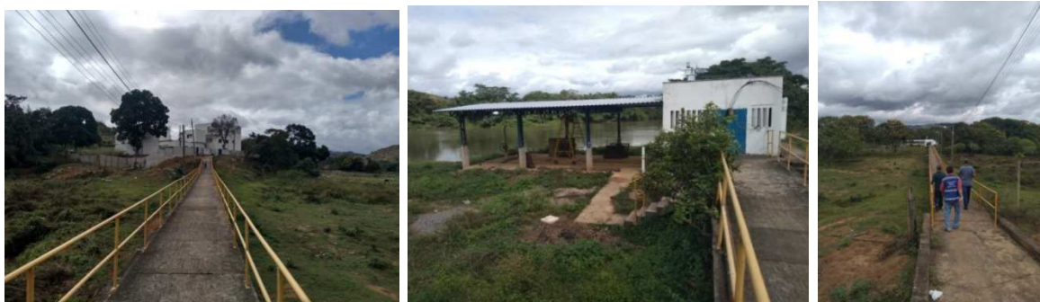
Acesso para a captação no Rio Muriaé sem sinalização identificando que o local é destinado ao abastecimento público
