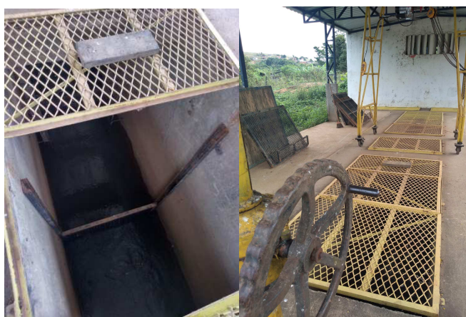
Gradeamento para remoção de sólidos grosseiros
