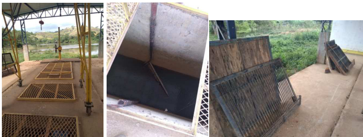
Gradeamento para remoção de sólidos grosseiros
