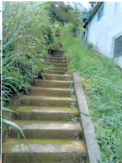
Acesso ao reservatório – Necessita de limpeza e corrimão
