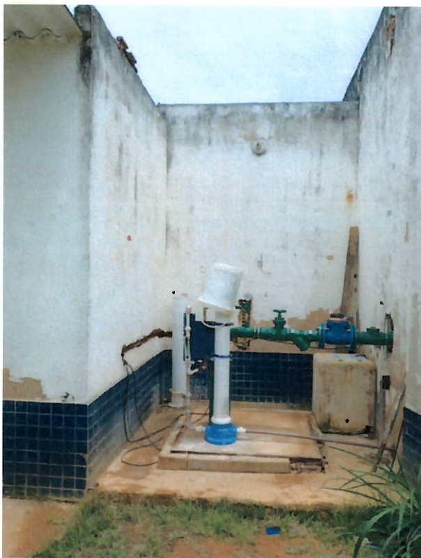
Barrilete do poço, sistema de desinfecção e fiação sem proteção
