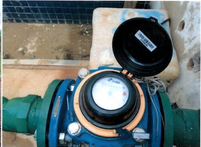
Saída recalque para o reservatório e Macromedidor
