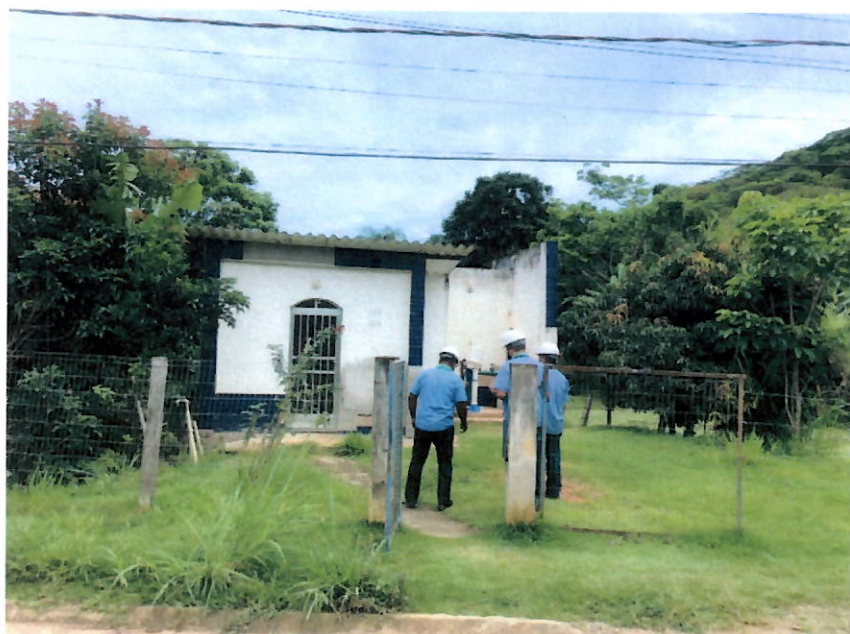
Sistema de Poço Profundo de Demétrio Ribeiro
