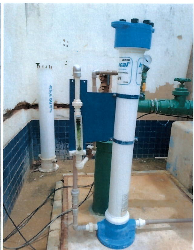
Barrilete do poço, sistema de desinfecção e fiação sem proteção
