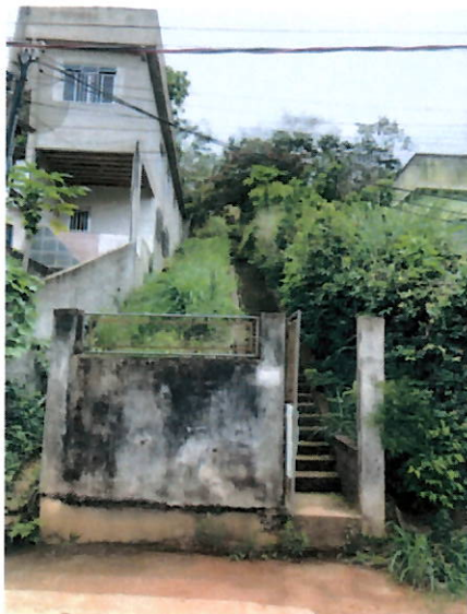
Acesso ao reservatório - Início
