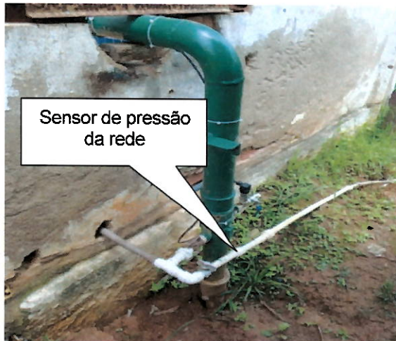
Saída recalque para o reservatório e Macromedidor
