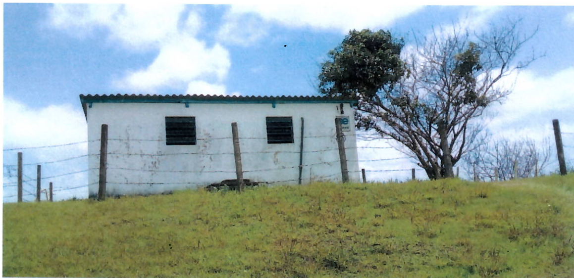
Entrada para o reservatório
