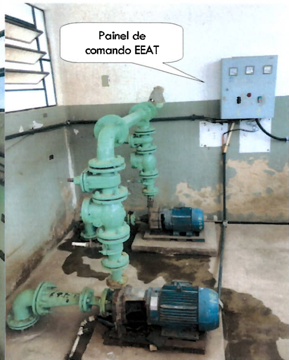
Motobomba de recalque de água tratada
