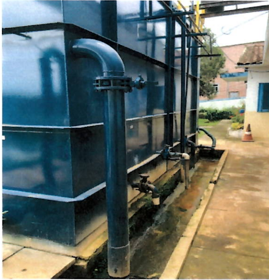
Registros de descarga com boa estanqueidade
