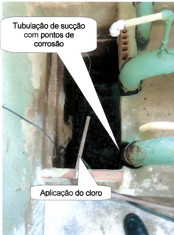
Tanque de contato sem tampa de proteção
