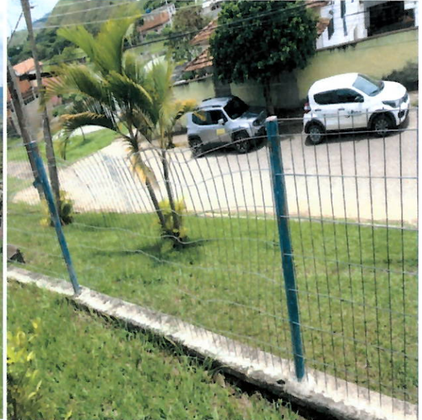
Parte frontal da ETA cercada com tela
