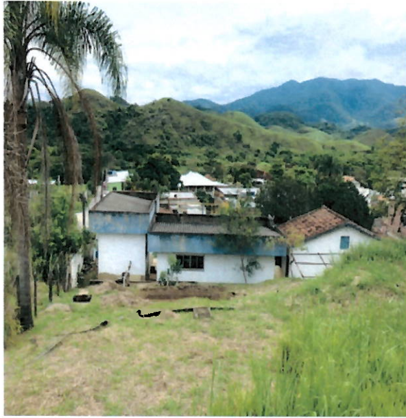
Vista da parte de trás da Estação
