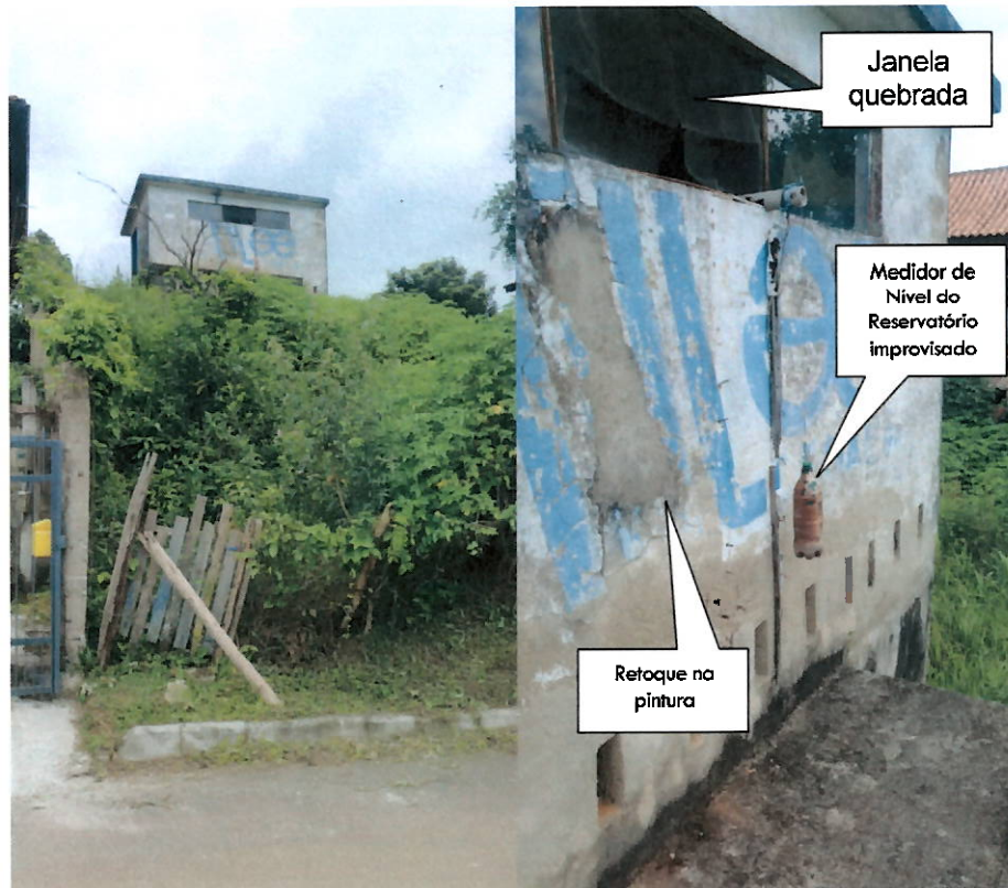
Reservatório de Massambará
