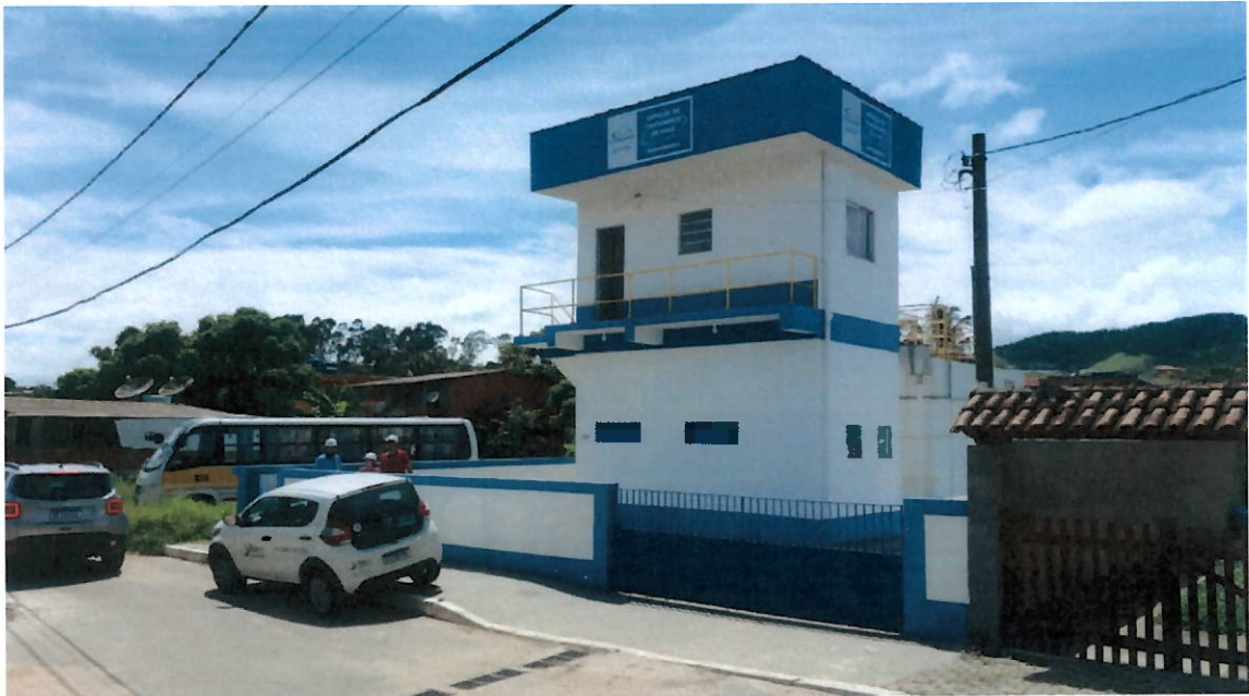
Entrada da ETA Massambará
