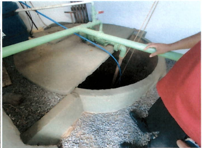
Poço da captação
