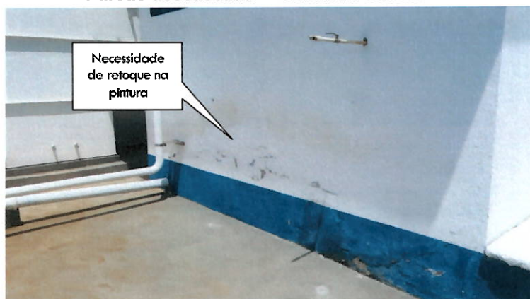
Parede externa da Casa de Bombas
