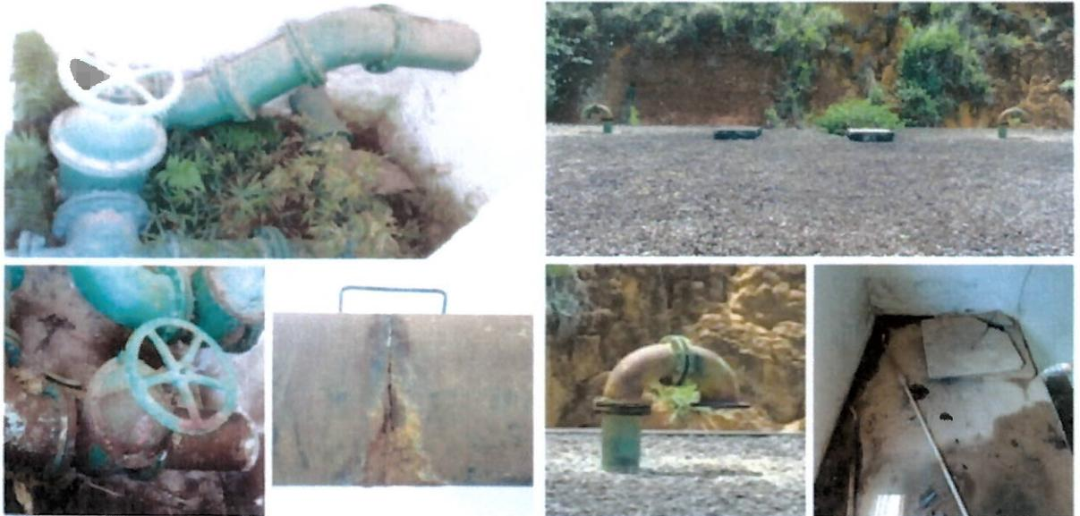
Tubulações e respiradouro do reservatório / Tampa avariada
