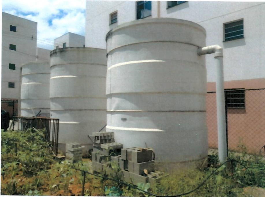
Foto 1 – Tanques anaeróbios
