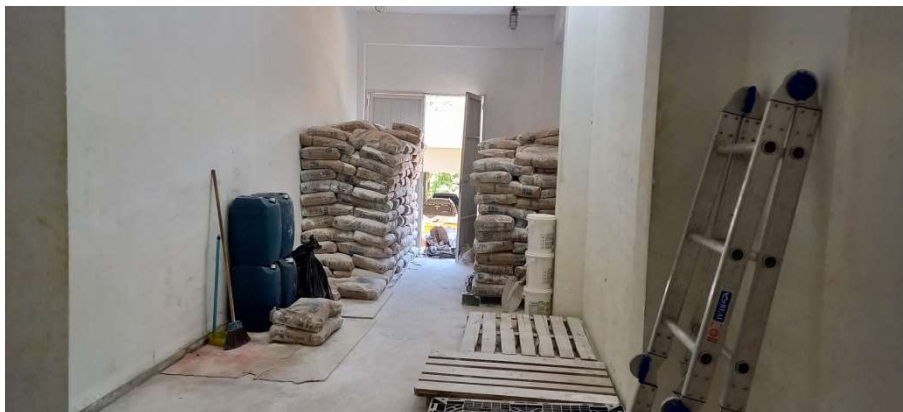
Fotografias 37 – Depósito de materiais em geral
