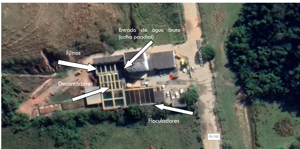
Imagem 1 – Imagem Aérea da Estação de Tratamento de Água de Rio Dourado
