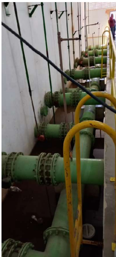
Fotografia 23 – Descargas dos filtros
