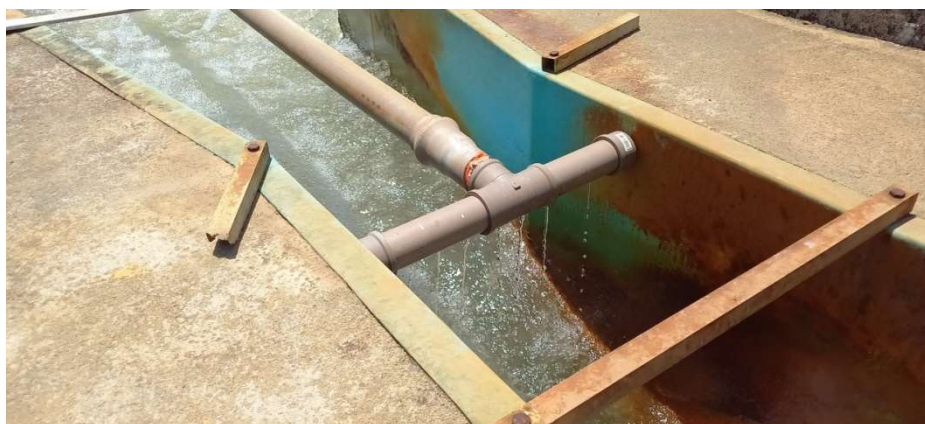
Fotografia 7 – Aplicação do coagulante
