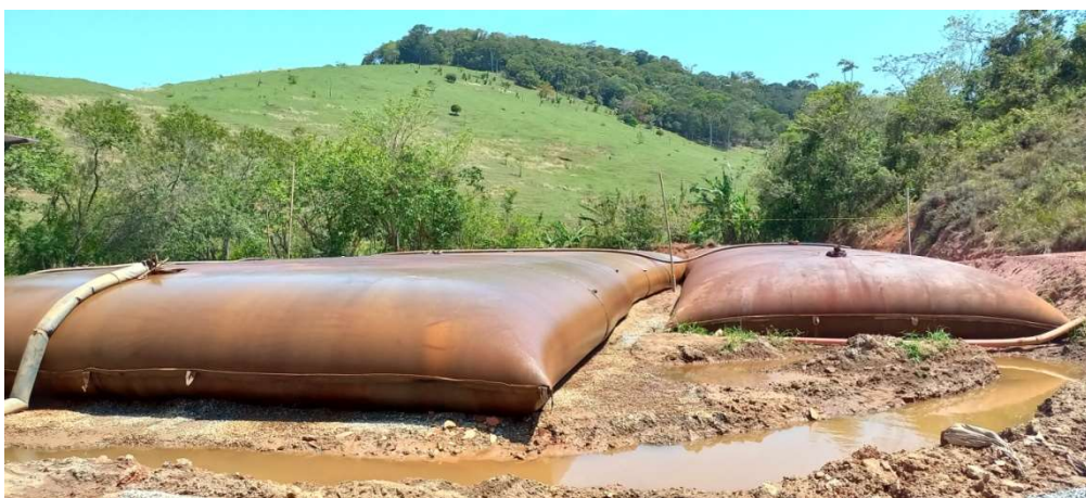
Fotografia 25 – Bags de armazenamento de lodo
