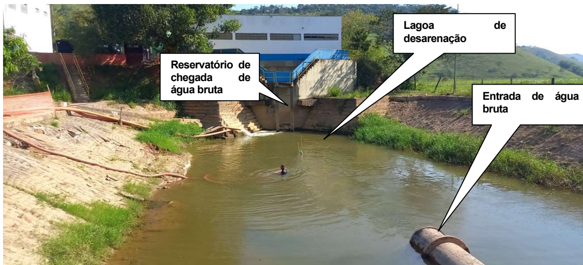
Fotografia 2 – Entrada de água bruta, lagoa de desarenação e reservatório de água bruta
