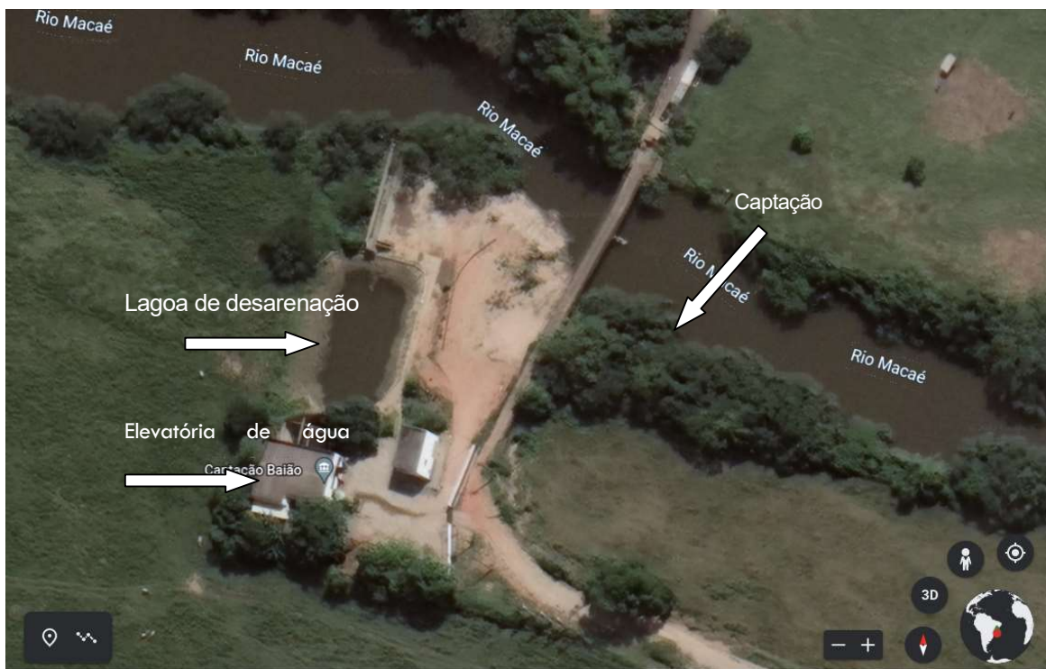
Imagem 1 - Imagem aérea da captação e sistema de bombeamento de água bruta.
