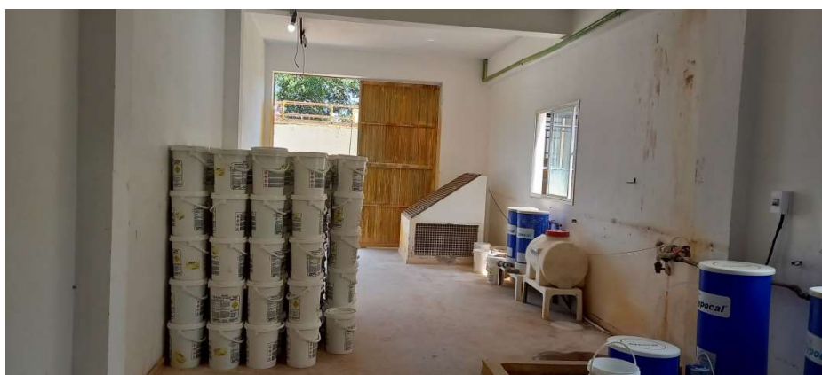
Fotografia 36 – Depósito de materiais de tratamento e sala de dosadores
