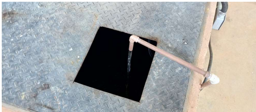
Fotografia 21 – Reservatório de contato
