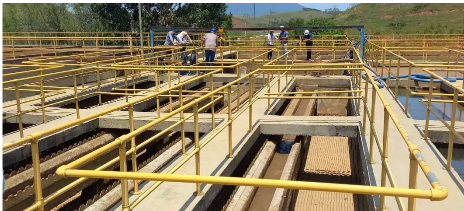
Fotografias 11, 12 e 13 – Decantadores de fluxo lamelar
