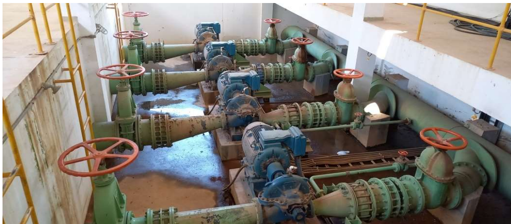
Fotografia 28 – Conjuntos Motor-Bomba
