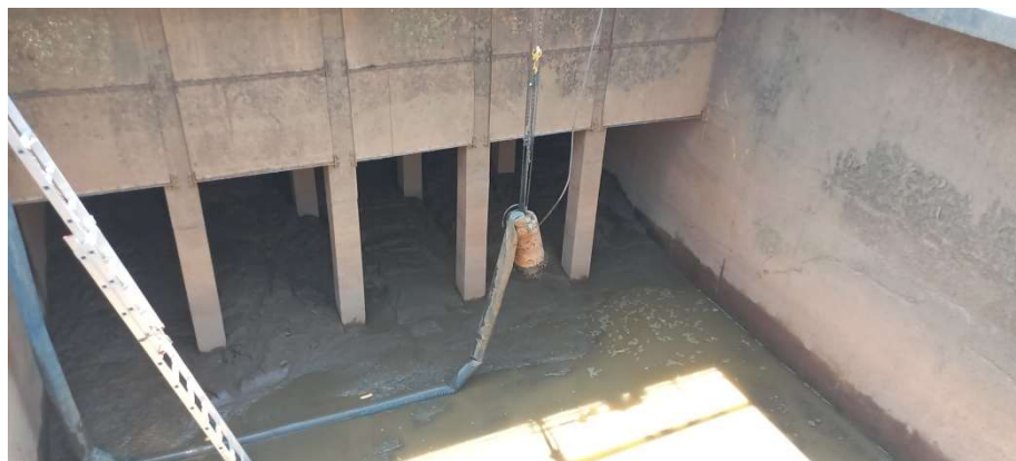
Fotografias 14, 15, 16 e 17 – Tanques de decantação sendo limpos.
