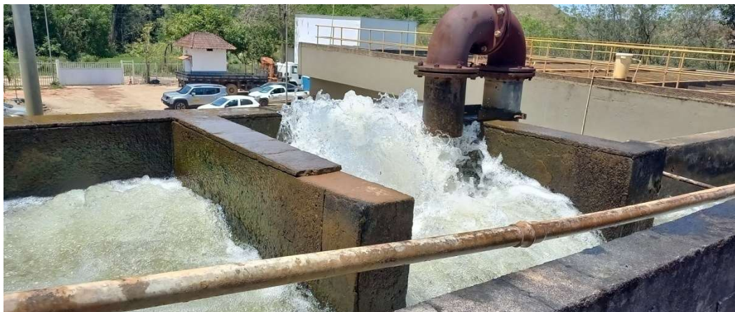
Fotografia 5 – Chegada da água bruta
