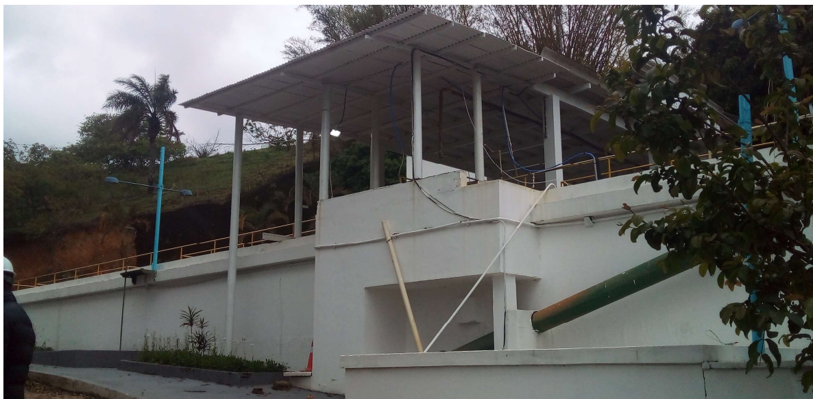
Vista frontal da entrada da ETA Paty do Alferes
