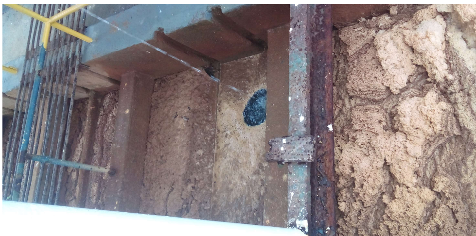
Floculador com muito material flutuante
