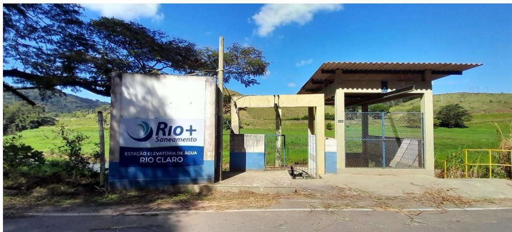
Captação da ETA de Rio Claro.
