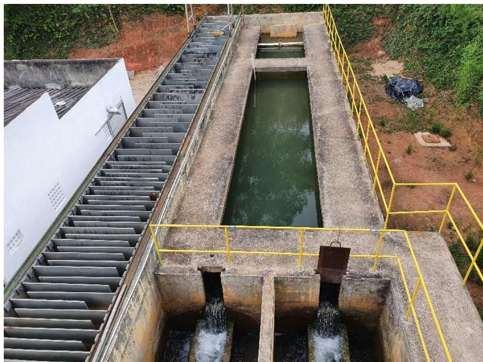
Foto 07 - Decantador de fluxo horizontal.
