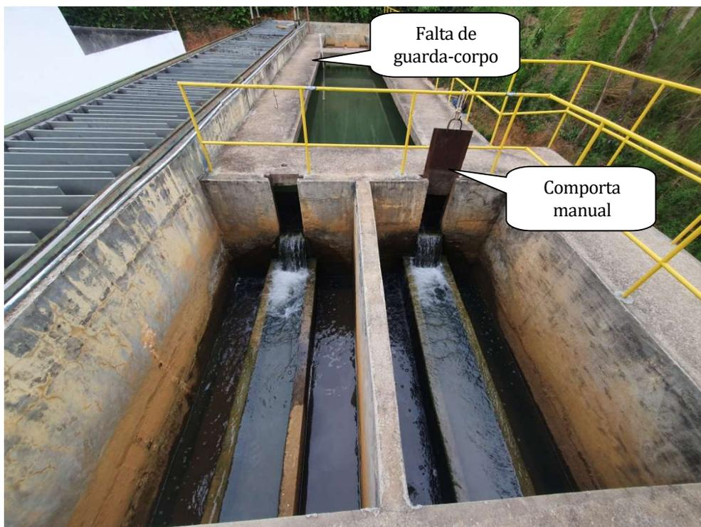
Foto 05 - Falta de Guarda-corpos em alguns pontos da ETA.
