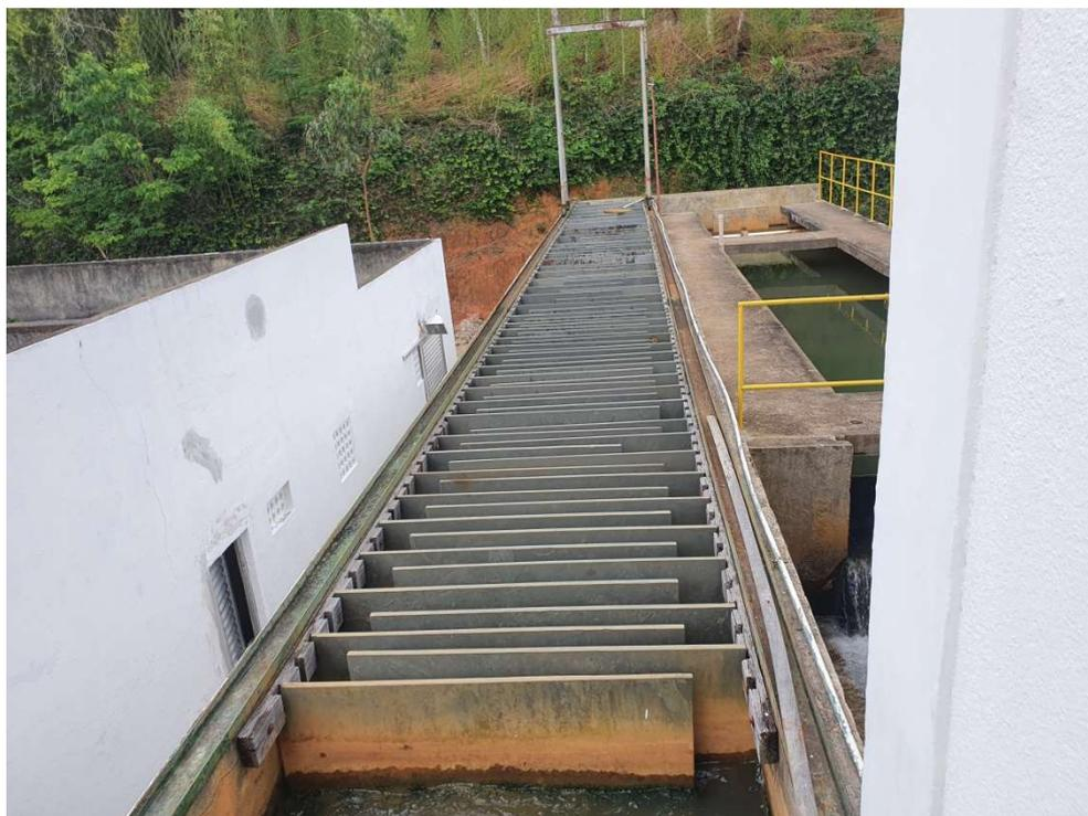
Foto 06 - Floculador de fluxo horizontal com chicanas de placas em Ardósia.
