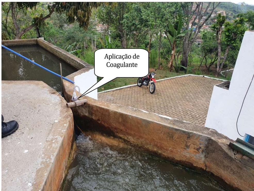
Foto 04 - Calha Parshall para leitura de vazão e aplicação do coagulante.
