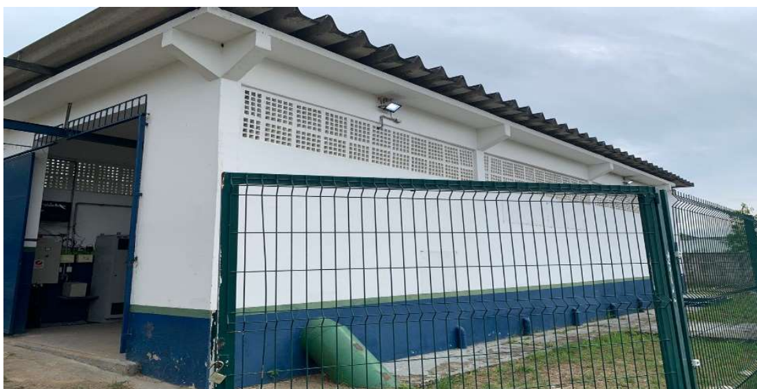
Elevatória não está identificada
