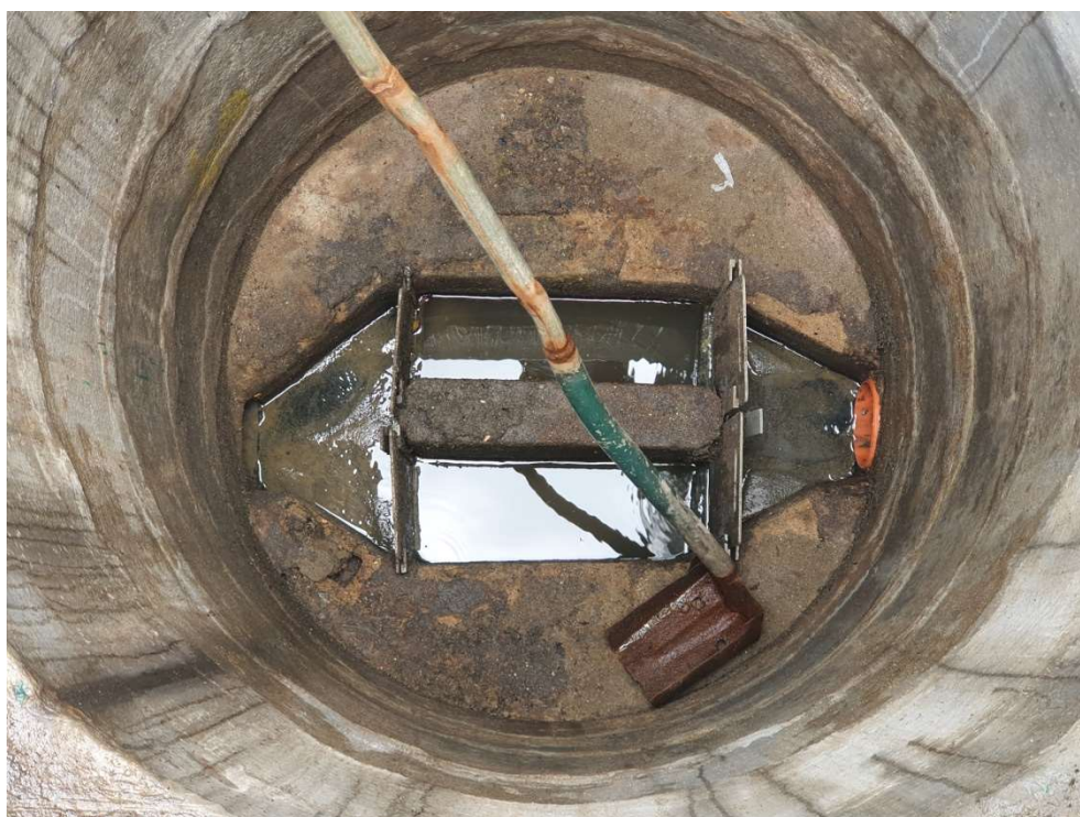
Foto 03 – Caixa de areia
