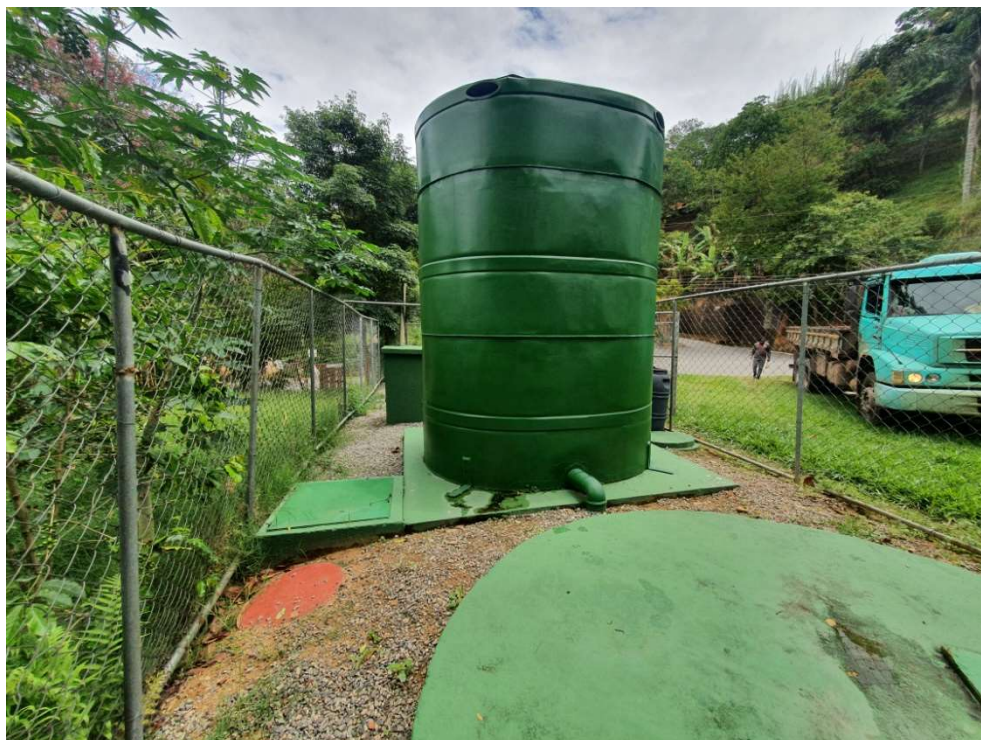
Foto 05 – Reator UASB
