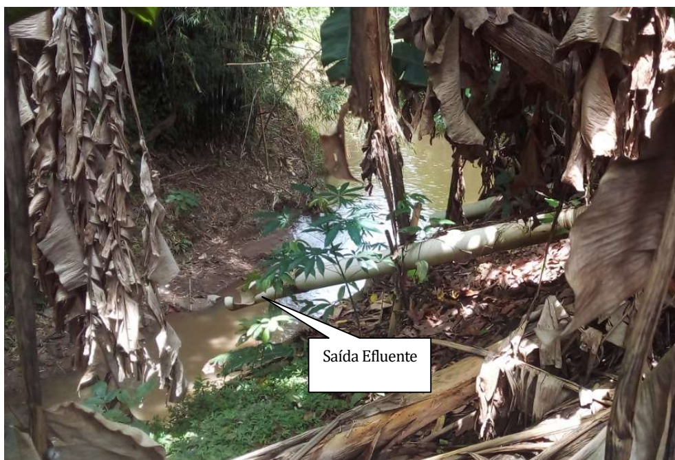
Foto 08 – Saída do efluente
