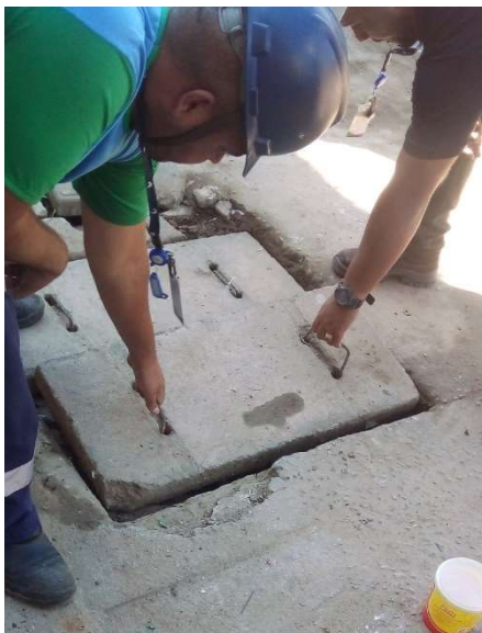
Remoção de Tampas de Concreto
