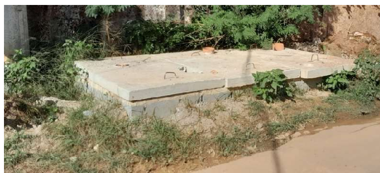
Casa de Válvulas para Manobra
