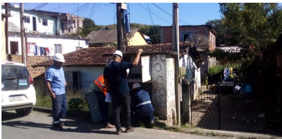
Inspeção do Booster
