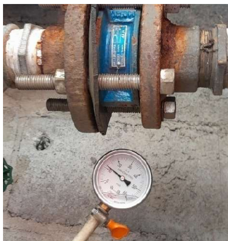
Pressão de Coluna d'água / Válvula de retenção
