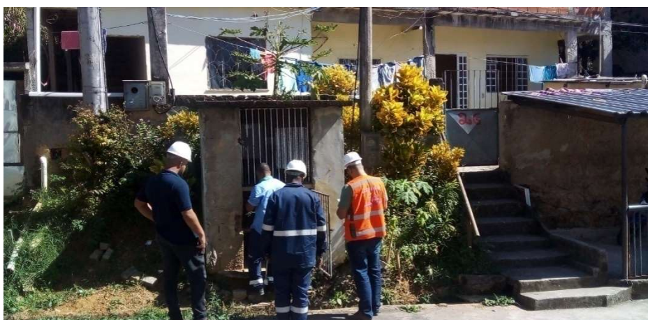
Inspeção do Booster
