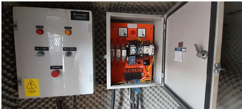
painel Elétrico Estrela Triangulo / painel C.C.O
