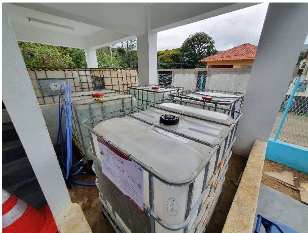
Foto 25 - Armazenamento de produtos químicos usados no tratamento
