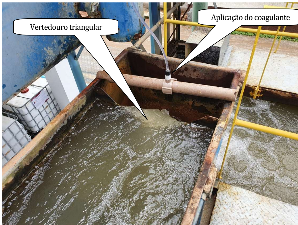
Foto 12 – Vertedouro triangular do Módulo 1
