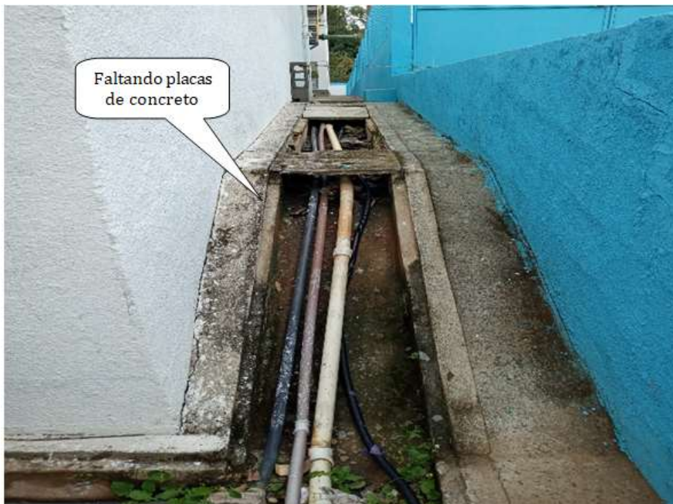
Foto 35 - Rampa de acesso à Elevatória de Água Tratada
