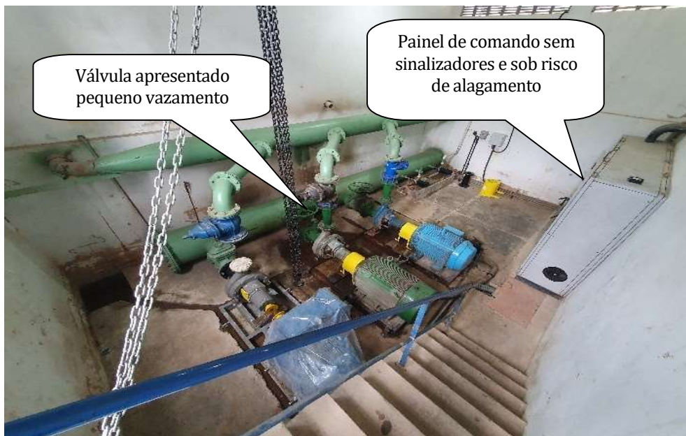
Foto 28 - Elevatória de água Tratada
