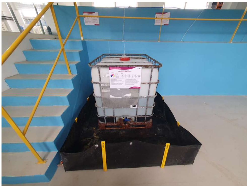
Foto 24 - Tanque de Flúor (ácido fluossilícico)
