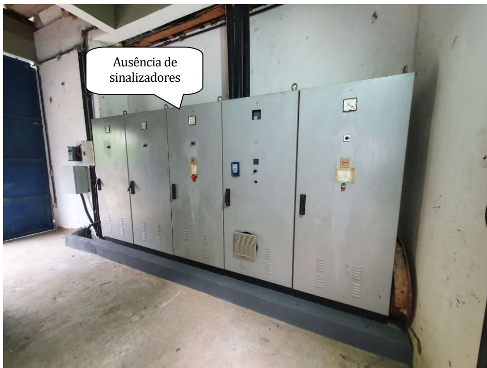
Foto 05 - PAINEL DE COMANDO DE MOTORES - 440V
