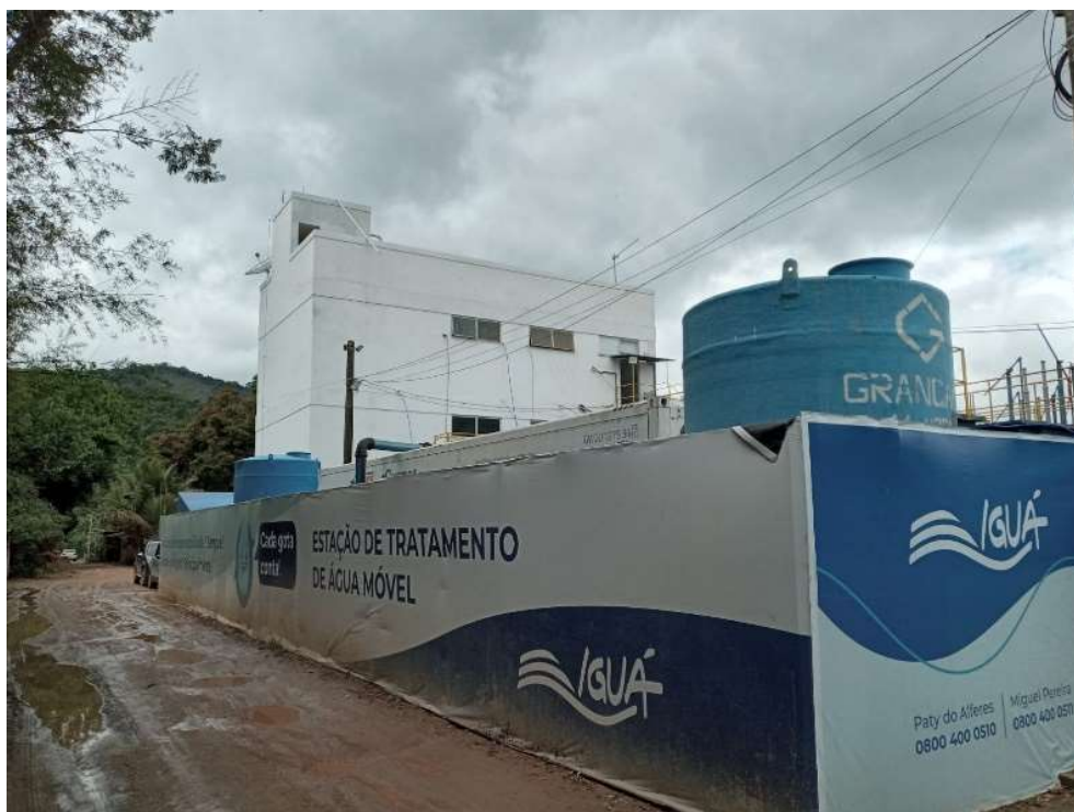
Acesso à ETA Fragoso
