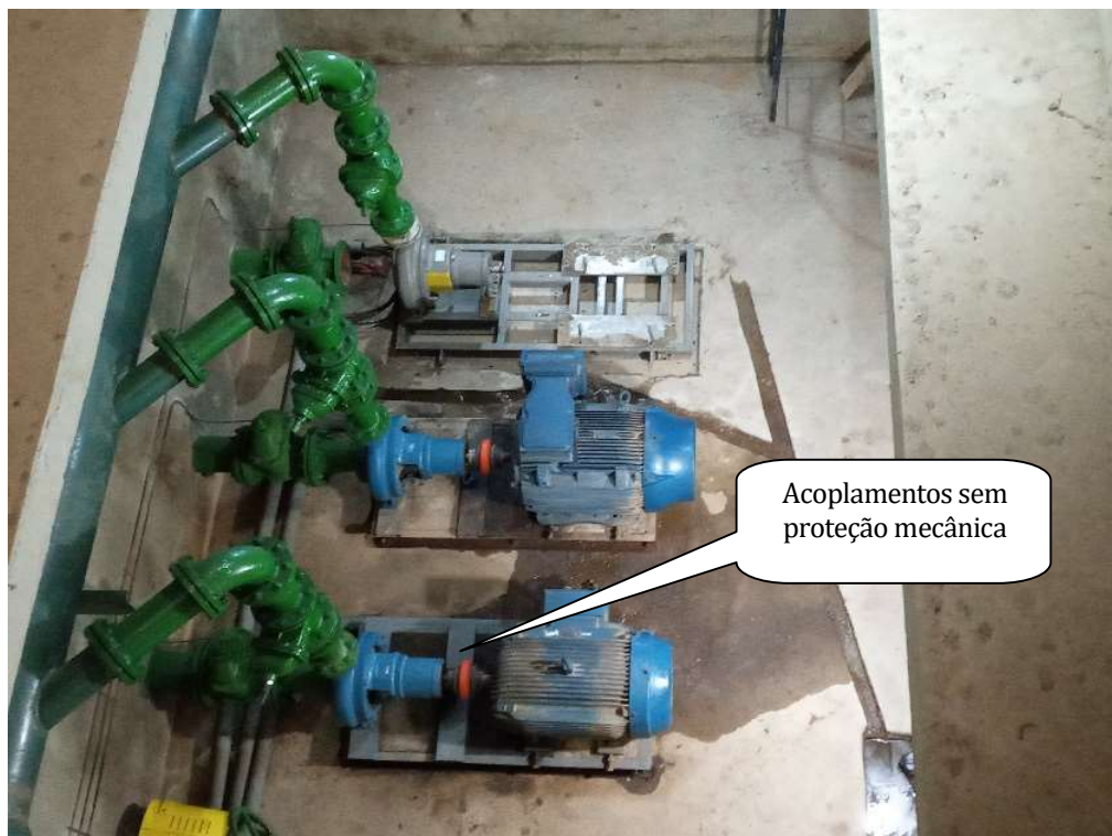
Foto 04 - Casa de bomba EEAB – sistema afogado
