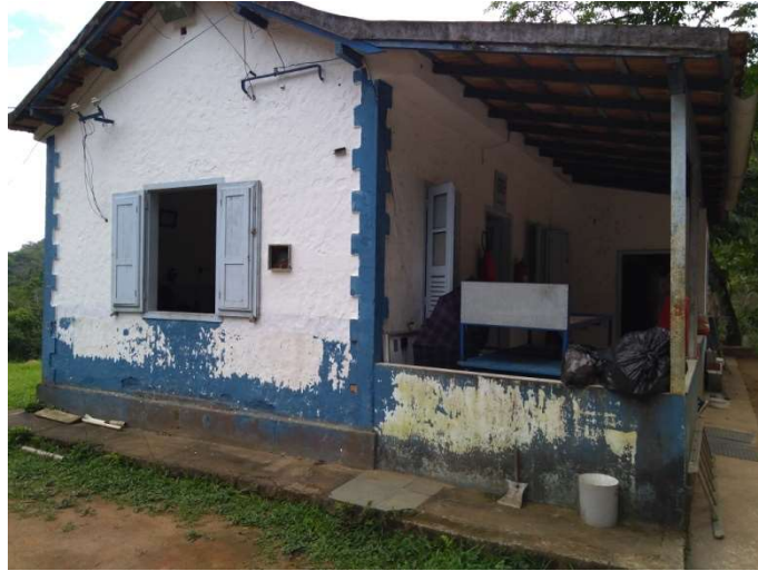
Foto 20 – Imóvel, Escritório, Cozinha e Banheiro da UT Xerém
