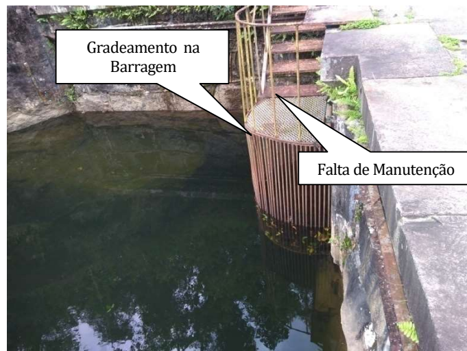
Foto 09 – Gradeamento de Retenção de Resíduos na Barragem
