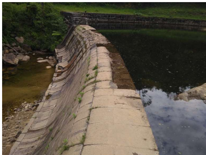
Foto 06 – Barragem da UT Xerém
