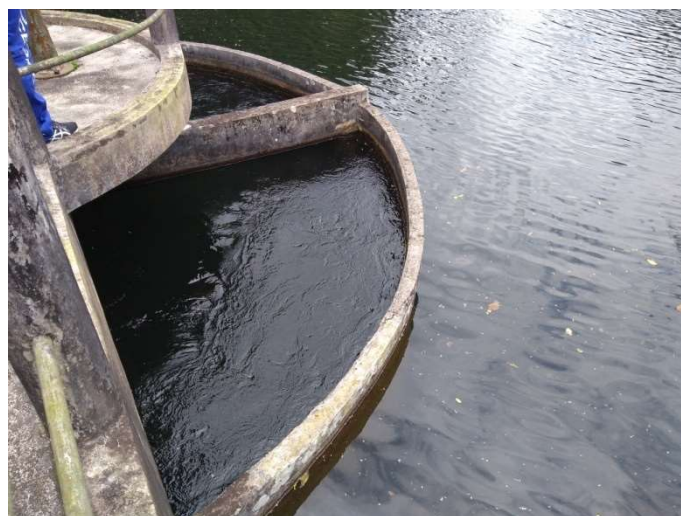
Foto 10 – Entrada da Água no Decantador
