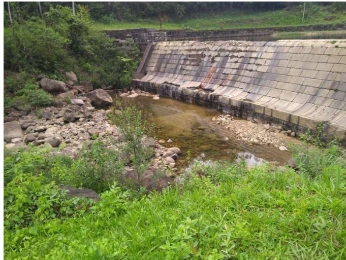
Foto 05 – Barragem da UT Xerém
