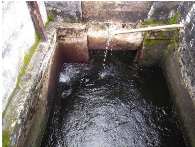
Foto 14 – Aplicação de Cloro na Saída do Decantadore
