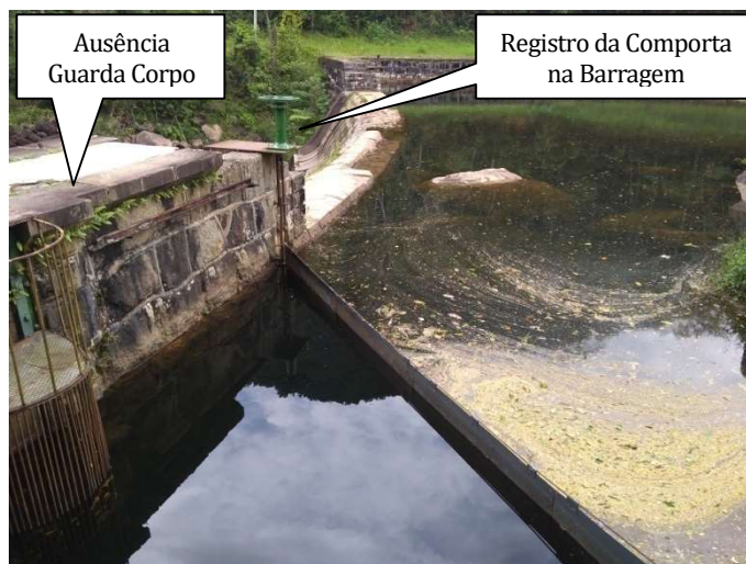
Foto 07 – Barragem da UT Xerém (comporta)
