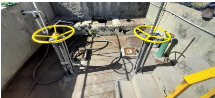
válvulas de saída do canal
