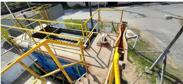
FOTO 7 NÃO CONFORMIDADE Assoalhos e escada da ETA precisando de reparos
