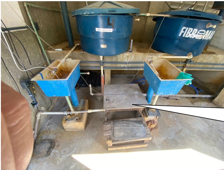
FOTO 7 NÃO CONFORMIDADE Assoalhos e escada da ETA precisando de reparos
