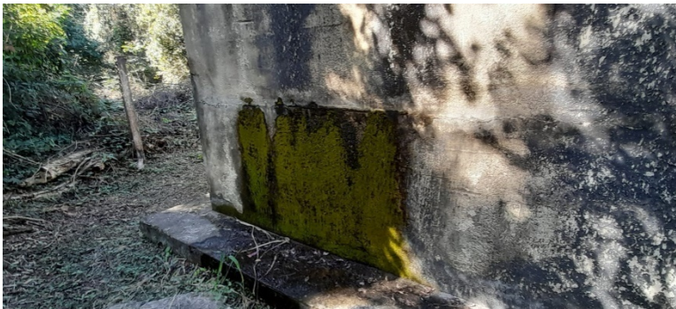
FOTO 10 NÃO CONFORMIDADE Vazamento na parede do reservatório
