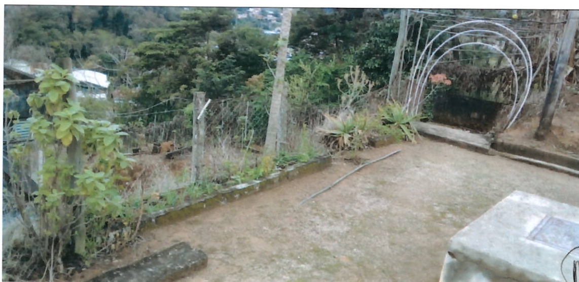
Acesso aos filtros e reservatório
