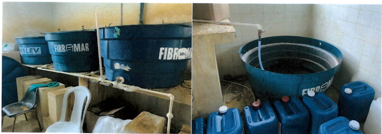
Depósito de produtos químicos
