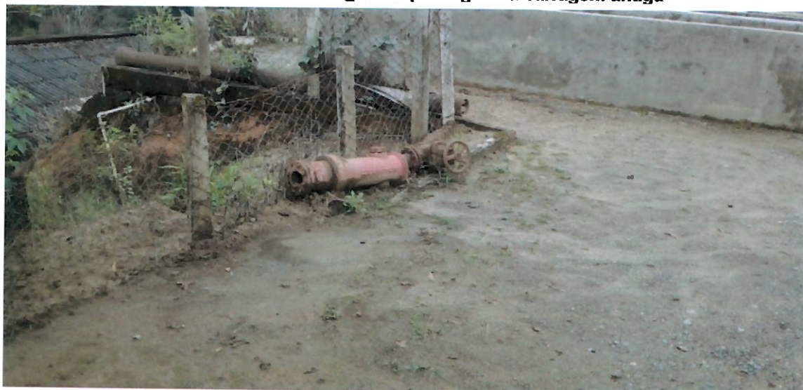
Peças hidráulicas espalhadas pelo pátio da ETA
