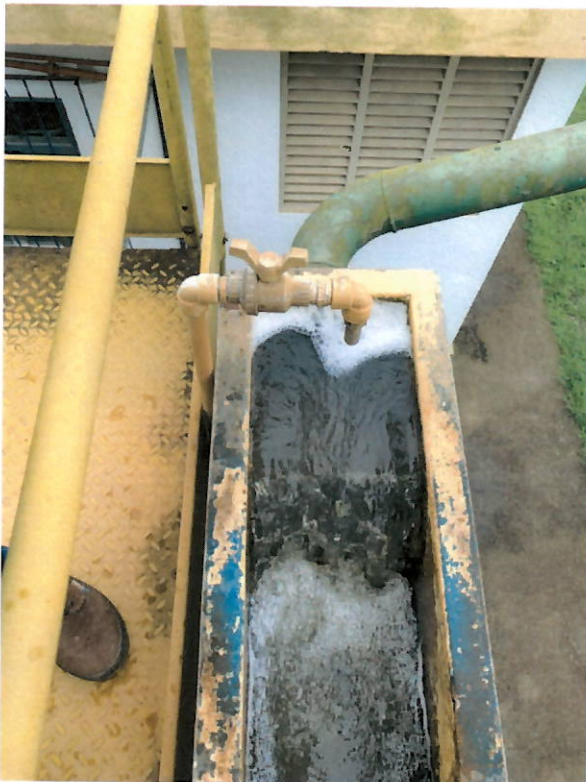
Chegada da água no canal de tranquilização e aplicação de Sulfato de Alumínio
