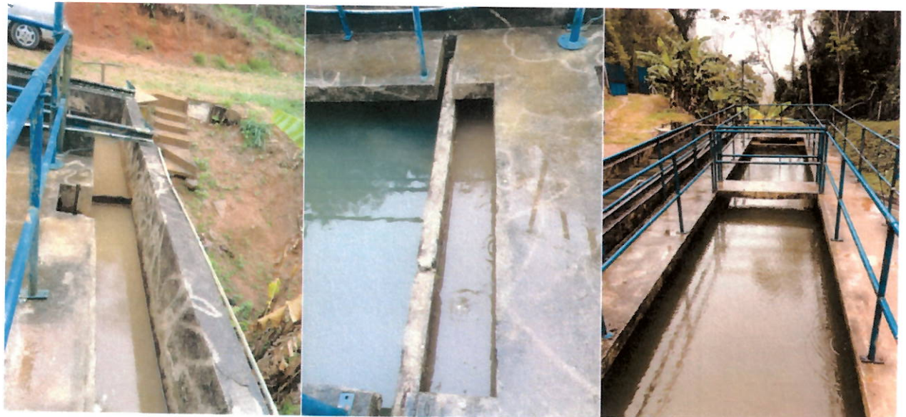
Canal de transição do Floculador para o Decantador
