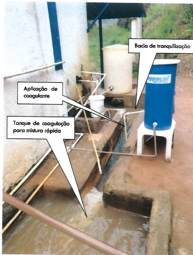
Chegada da água na Estação
