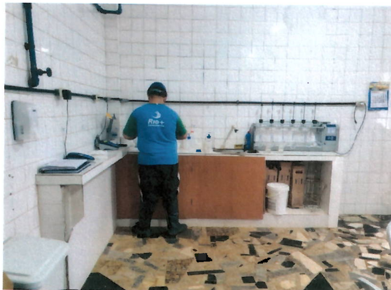
Operador realizando testes no laboratório da ETA
