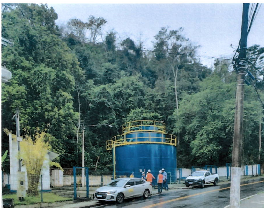
Entrada da ETE Piraí 2
