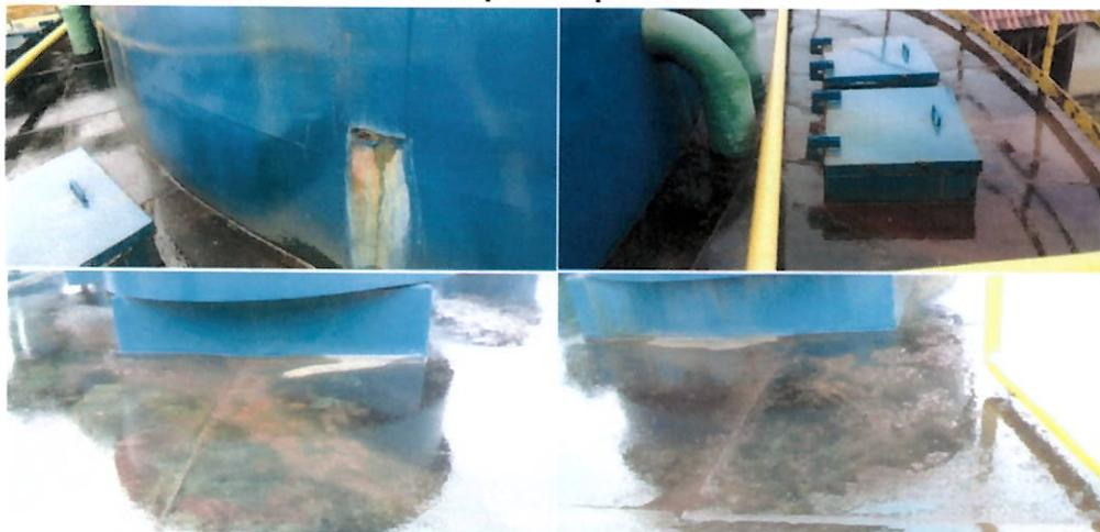
**Parte superior de Reator apresentando pontos de corrosão**
