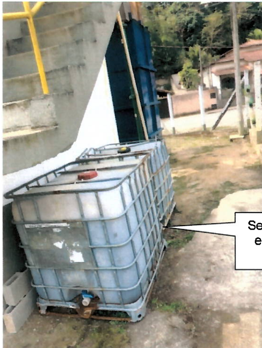
Caixa de armazenamento de sulfato
