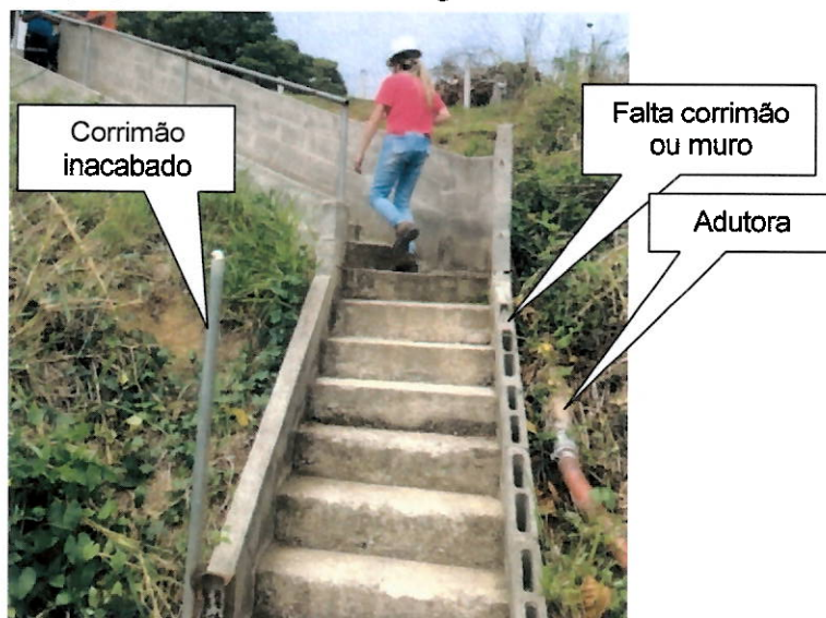
Acesso à captação
