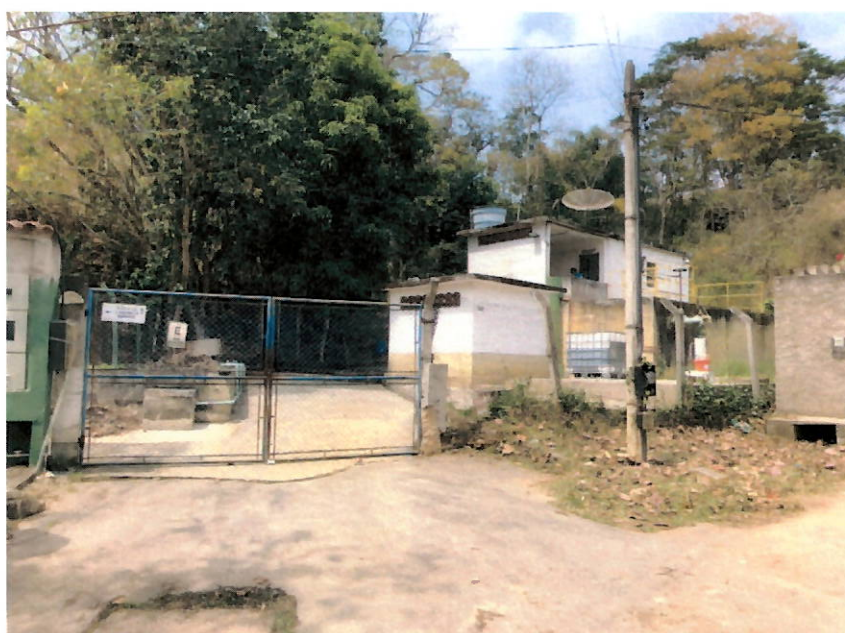
Estação de Tratamento de Água de Rosa Machado
