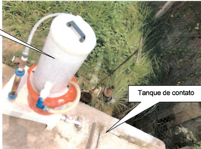
Sistema de desinfecção com pastilha de Hypocal
