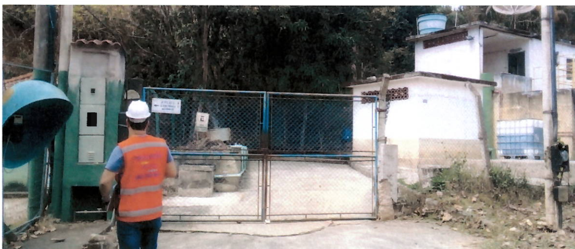
Entrada da ETA Pirai sem identificação na entrada
