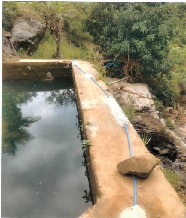
Foto 10 – Tubulação PEAD de 20 mm que conduz o cloro até a tubulação tronco
