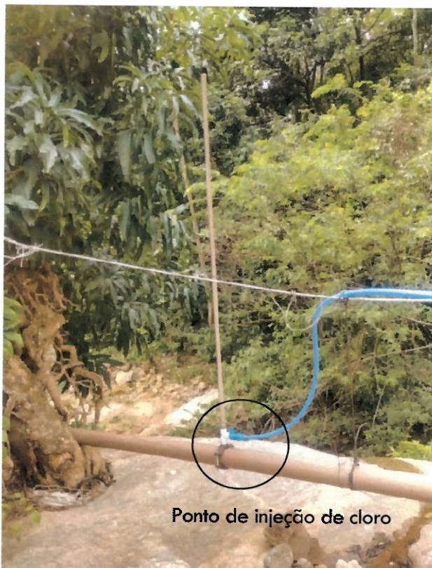
Foto 11 – Tubulação PEAD de 20 mm injetando o cloro na tubulação tronco e leito do rio Mole
