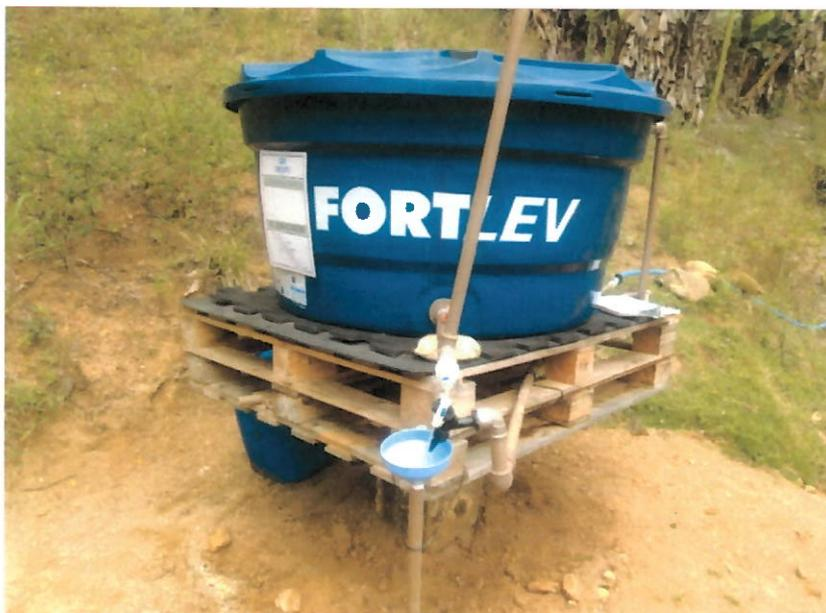
Foto 06 – Reservatório onde é depositado o cloro
