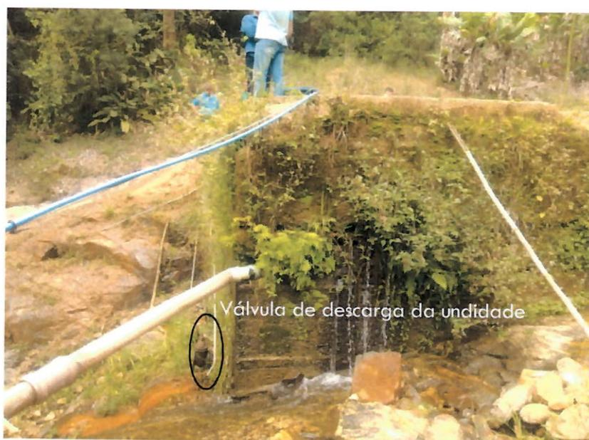
Foto 03 – Barragem da Unidade de Tratamento de Água Boa Esperança Nova e válvula de descarga da Unidade
