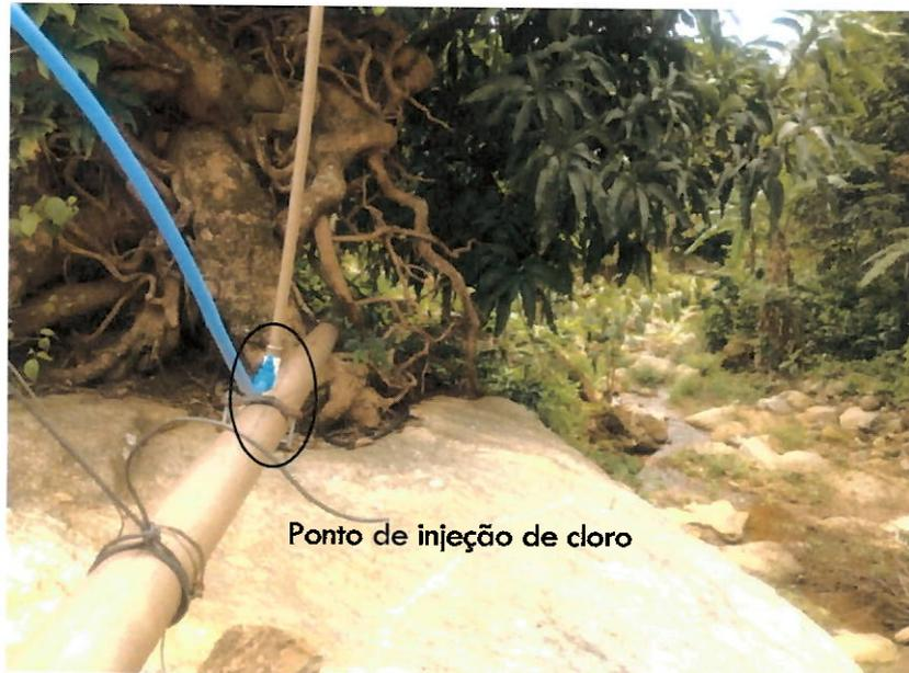
Foto 12 – Tubulação PEAD de 20 mm injetando o cloro na tubulação tronco e leito do rio Mole
