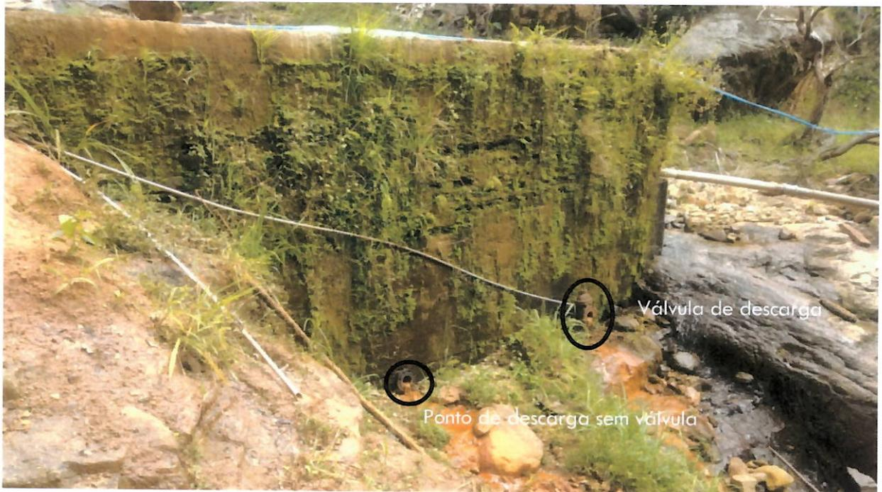
Foto 16 – Válvula de descarga da barragem e um outro ponto de descarga sem válvula
