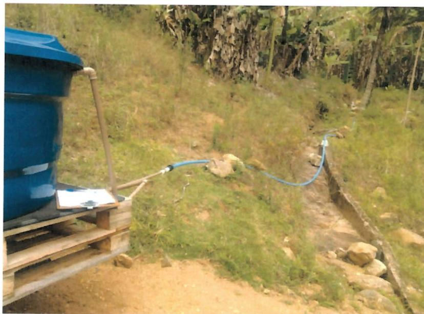
Foto 13 – Tubulação PEAD de 20 mm que capta água do rio Mole para ajudar a carrear o cloro para a tubulação tronco
