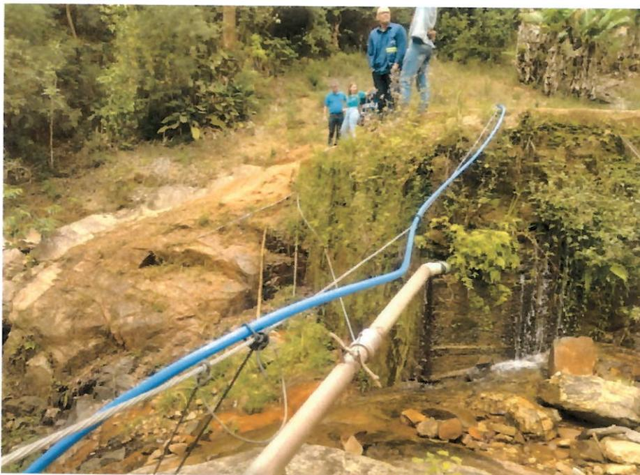
Foto 17 – Tubulação tronco e tubulação PEAD DN 20 mm condutora de cloro até a tubulação tronco
