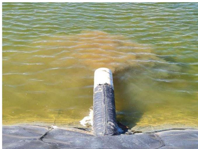
Foto 12 – Saída de esgoto para lagoa de decantação.
