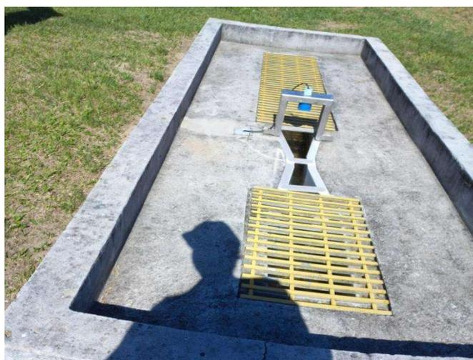
Foto 21 – Calha Parshall com medidor de vazão Ultrassônico na saída do esgoto tratado.
