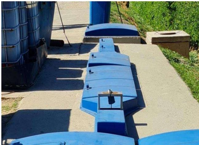
Foto 05 – Calha Parshall com Medidor de Vazão Ultrassônico (Com tampa).
