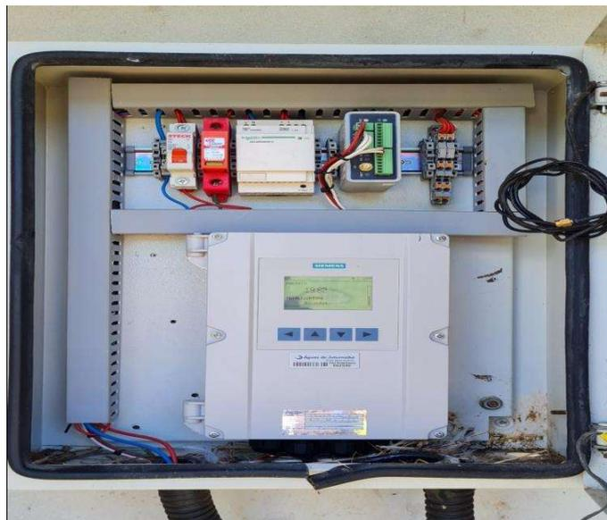
Foto 07 – Painel Medidor de Vazão 3,11 l/s.
