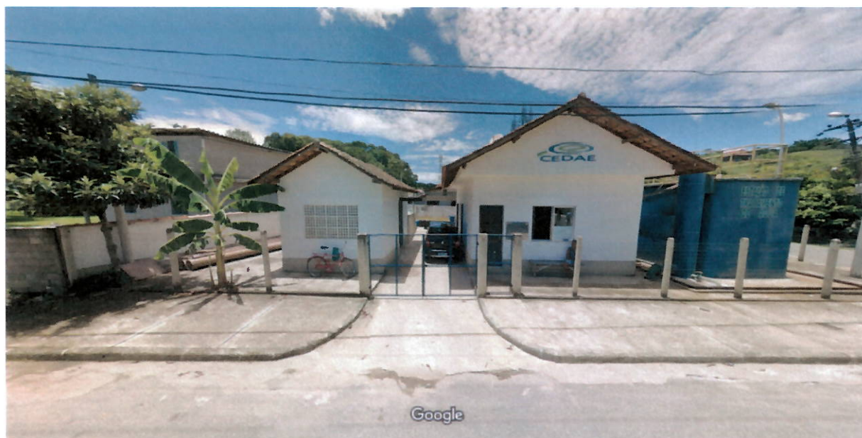
Entrada da ETA Ipiabas (Google)
