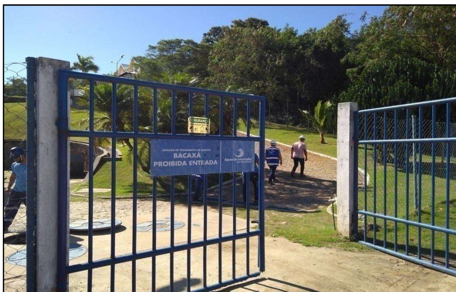
Entrada da Estação de Tratamento de Esgoto Bacaxá
