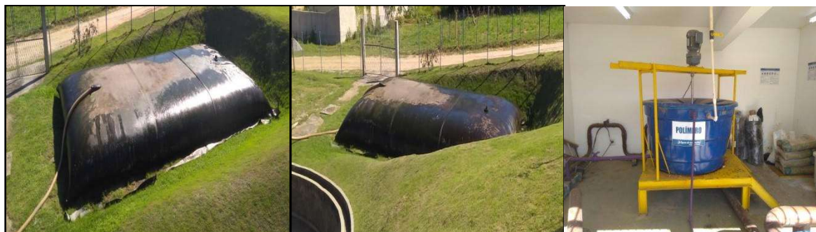
Figura 9 – Tratamento do lodo: do FBAS para o tubo geotéxtil (geobag), para realizar desidratação (secagem), auxiliada pela aplicação de polímeros oriundos do tanque de mistura.
