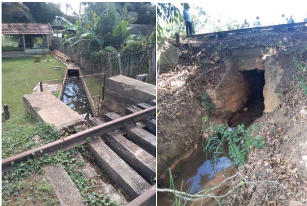
Lançamento de Esgoto
