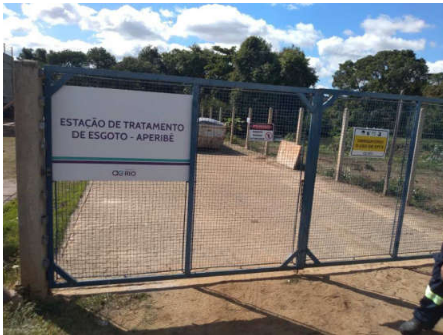
Entrada da Estação de Tratamento de Esgoto
