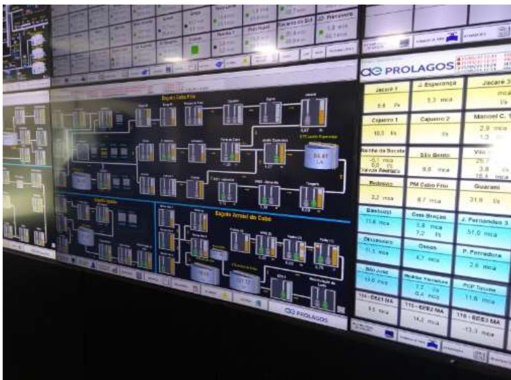
Foto 02 – Informações em tempo real sobre as condições de trabalho das elevatórias de esgoto
