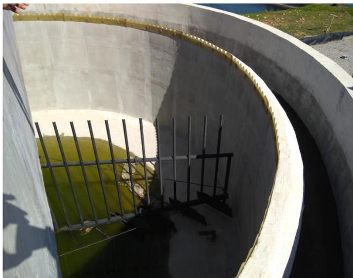
Foto 12 – Tanque de decantação com líquido indevido no fundo
