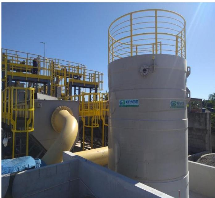
Foto 02 – P-TRAT Sistema de pré-tratamento composto por um canal, uma peneira de canal e 2 transportadores de rosca helicoidal agrupados em um único conjunto
