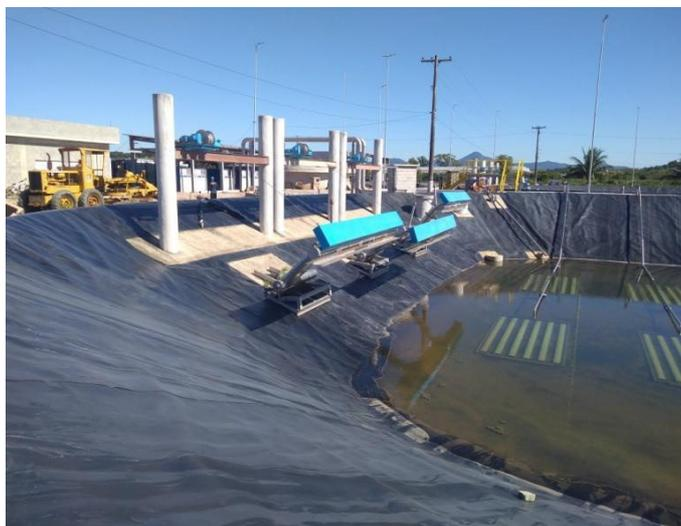
Foto 05 – Posicionamento dos Skimmers que coletam os efluentes tratados
