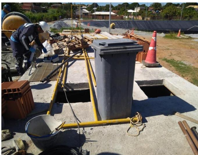
Foto 07 – Materiais e ferramentas espalhados de forma desorganizada e com risco de gerar acidentes
