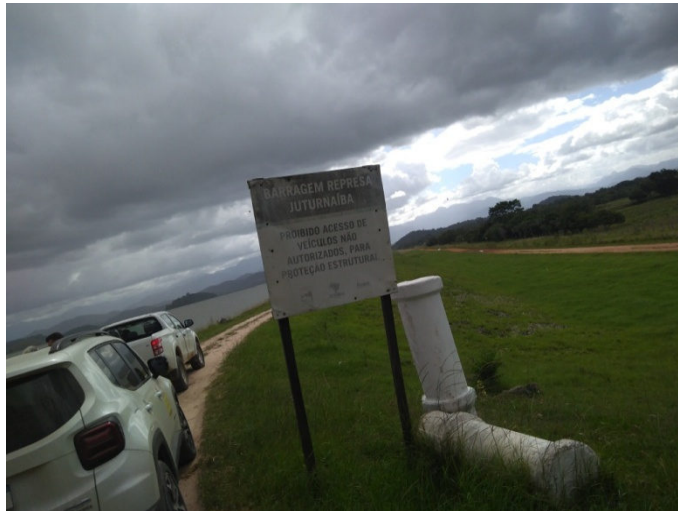
Foto 01 – Entrada da Estrada da Barragem Margem direita
