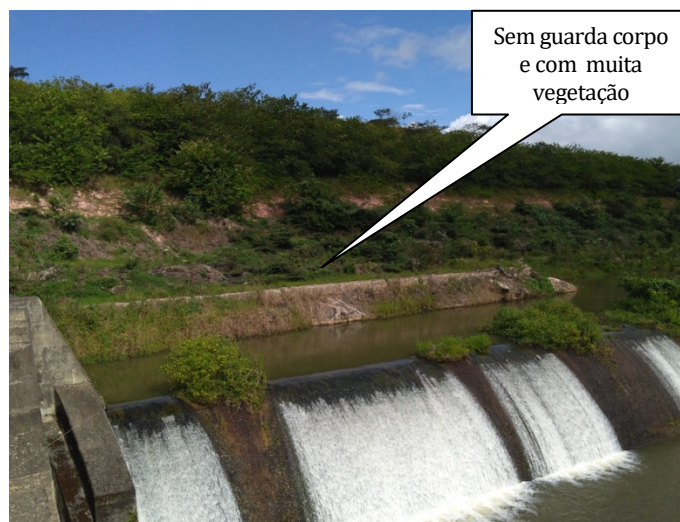
Foto 11 – Lateral Esquerda dos Vertedouros (Sem Corpo e com muita vegetação)
