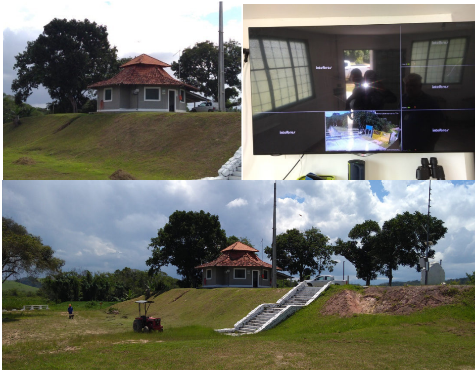
Escritório da Barragem
