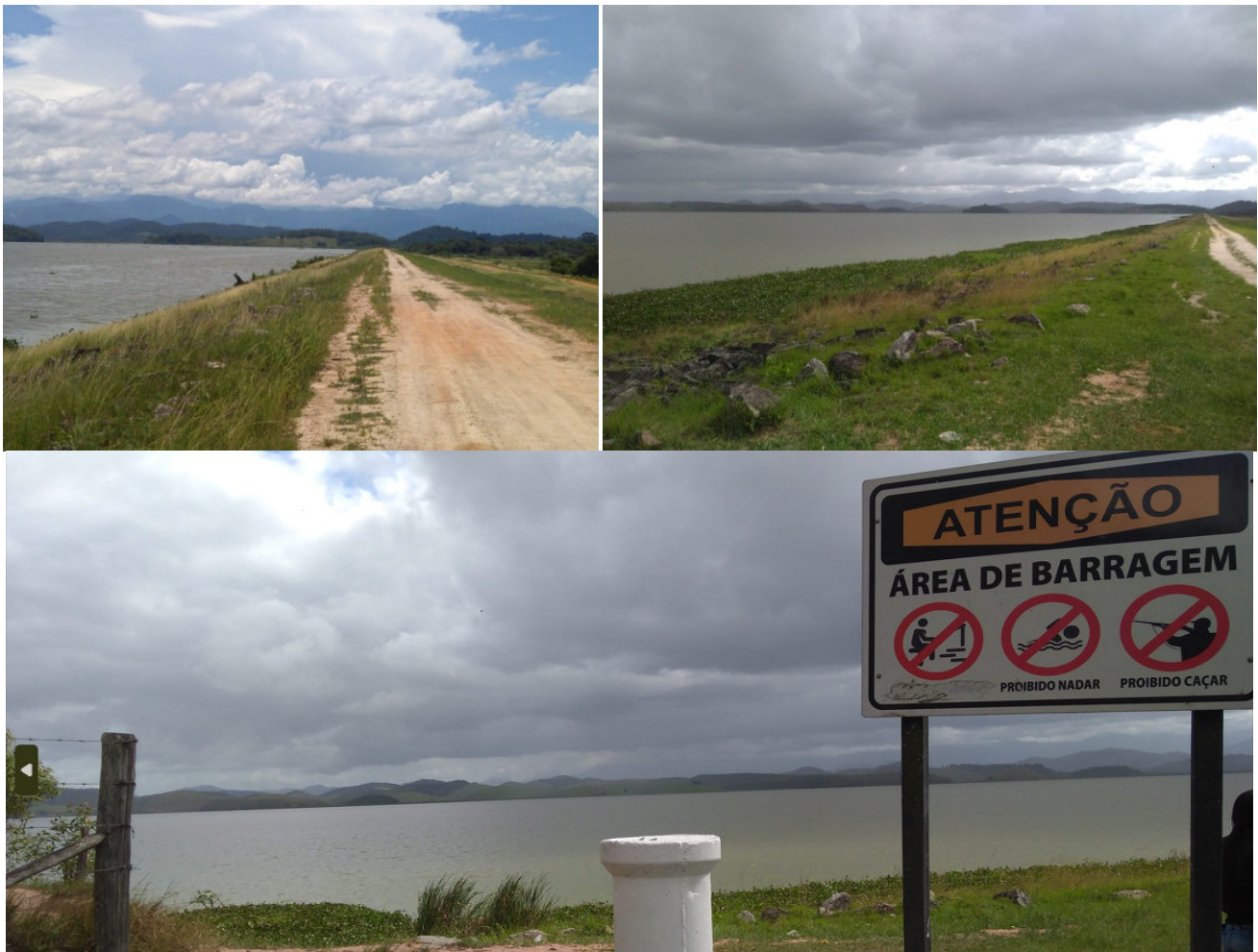
Foto 02 – Estrada da Barragem Margem direita
