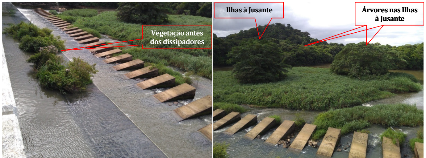
Foto 07 – Vegetação à Jusante da Barragem
