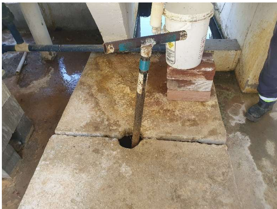
Foto 04 – Chave do registro de controle da vazão
