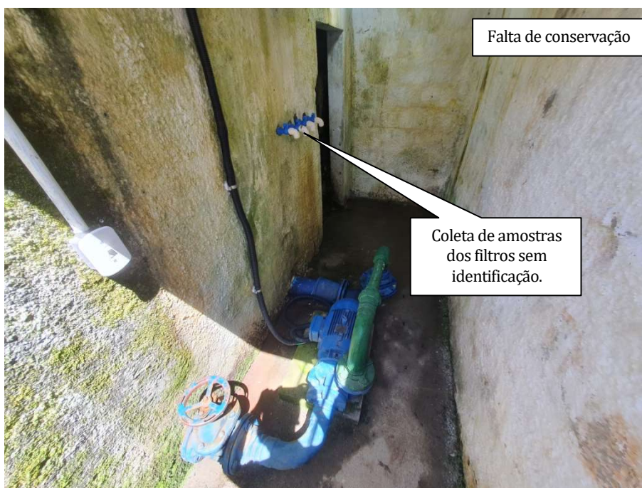
Foto 12 – Bomba para limpeza dos filtros
