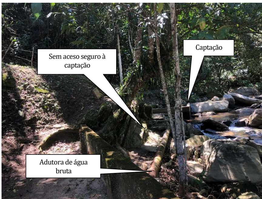
Foto 02 – Acesso à Captação
