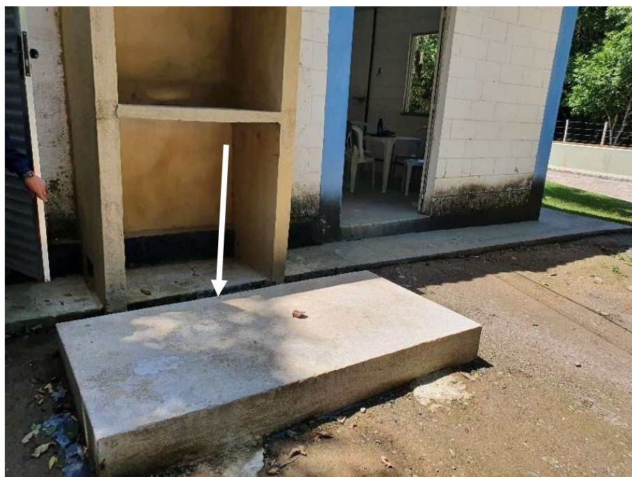
Foto 22 – Local destinado ao gerador de energia elétrica
