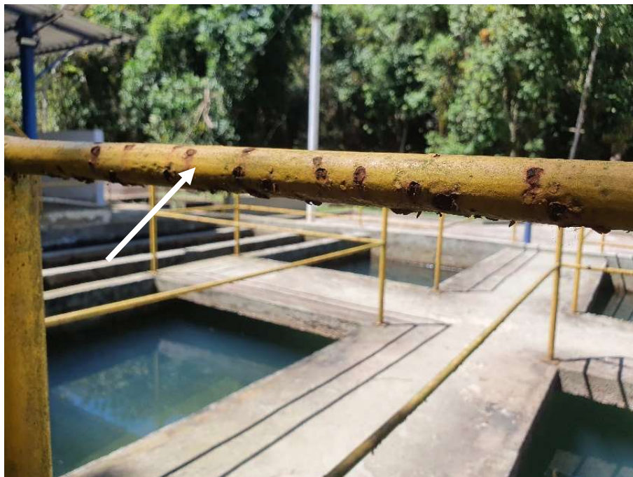
Foto 08 – Guarda-Corpo do Decantador
