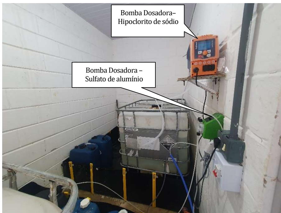
Foto 21 – casa de produtos químicos
