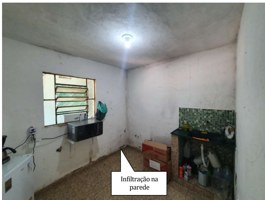
Foto 24 – Sala do operador
