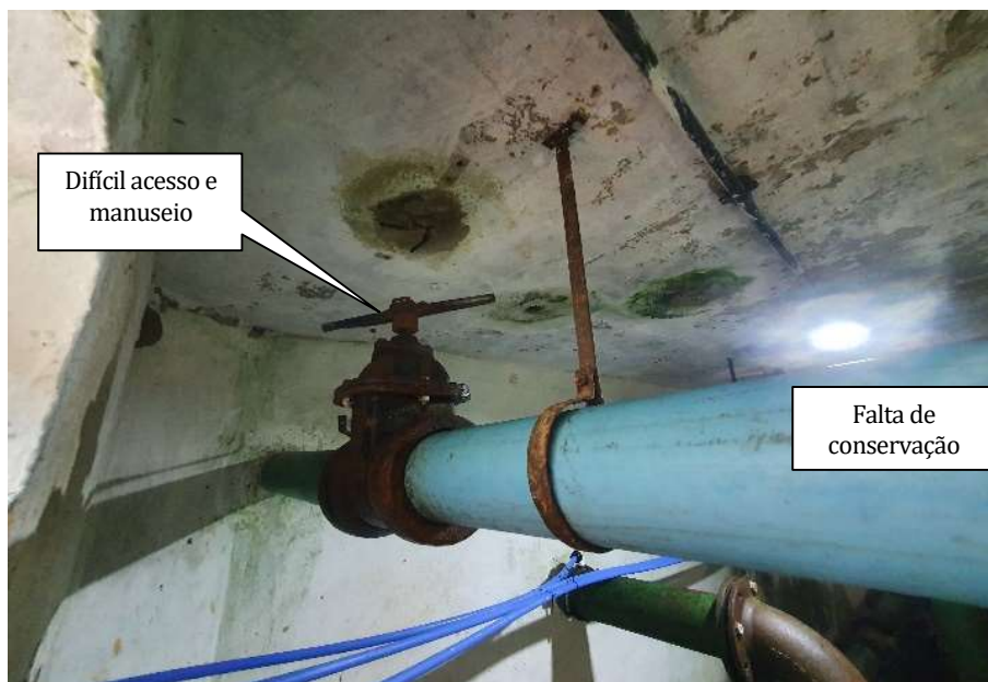
Foto 14 – Registro decantador/filtro
