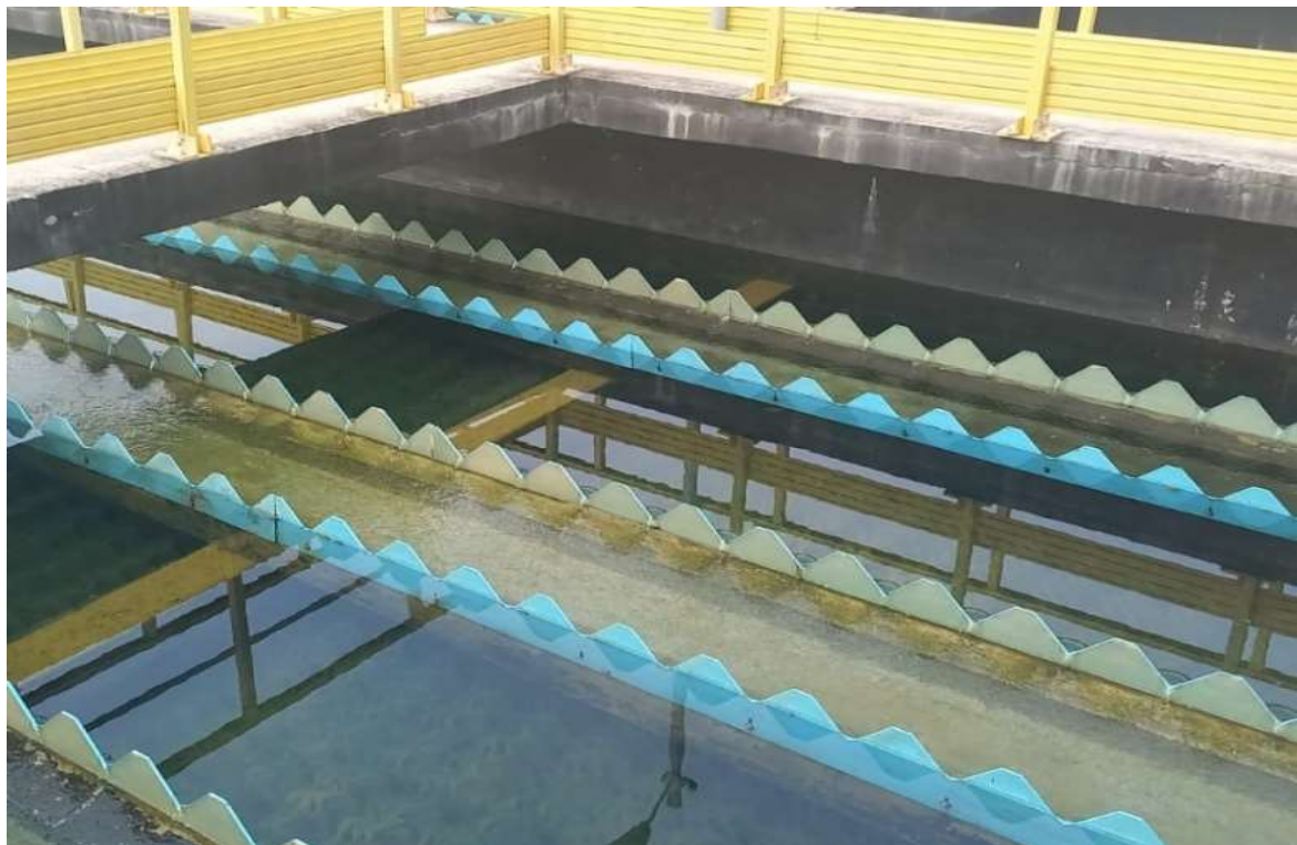
3 (três) Decantadores
