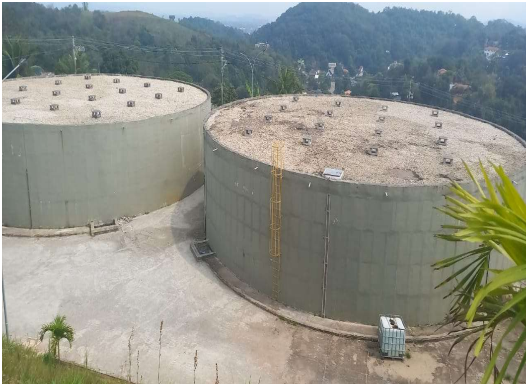
Reservatórios de Água Tratada 5 Milhões de Litros D'Água
