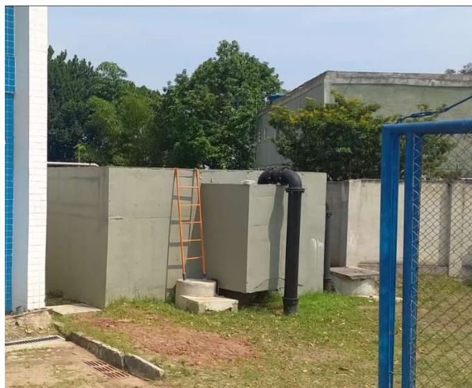
Foto 21 – Tanque de Homogeneizado de Lodo 9000 litros
