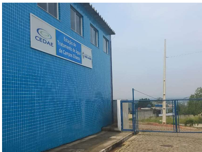
Foto 02 – Alameda Principal da ETA
