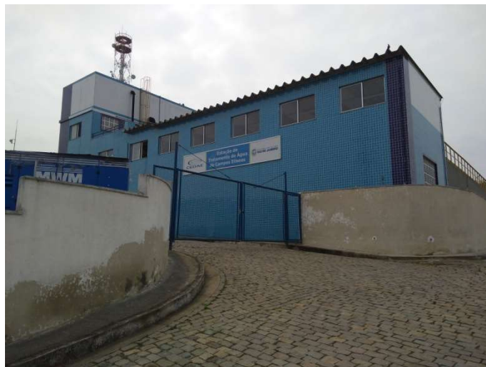
Foto 01 – Entrada da Estação de Tratamento de Água Campos Eliseo
