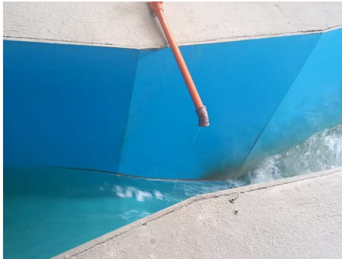
Foto 07 – Aplicação de Sulfato de Alumínio na Calha Parshall
