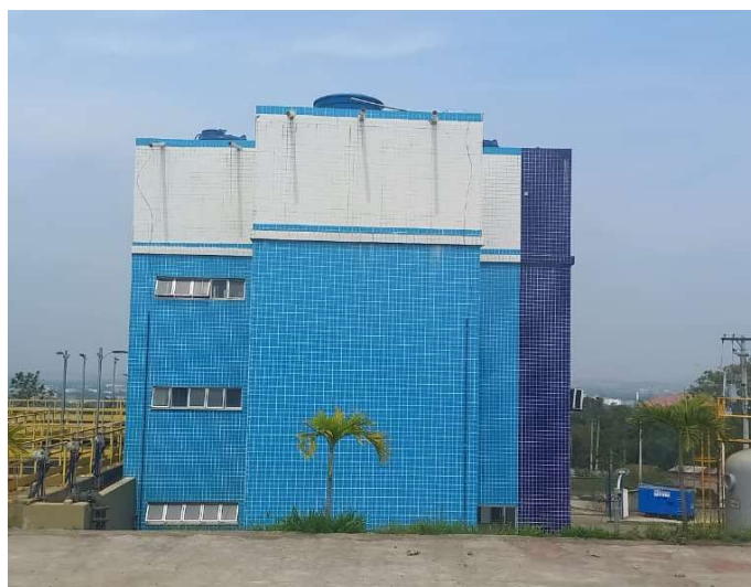
Foto 03 – Vista Lateral do Prédio da ETA
