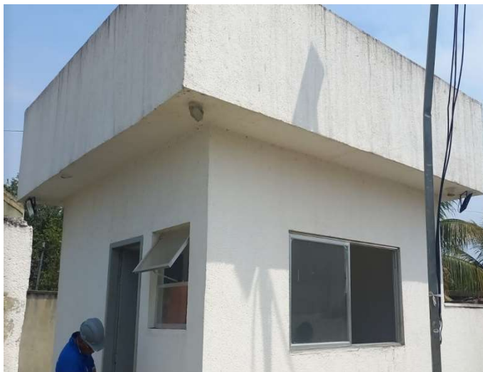
Foto 04 – Guarita na Entrada da ETA Campos Eliseo
