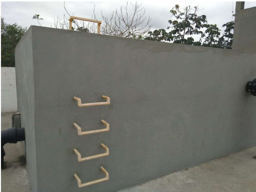
Fotografia 17 – Tanque de Decantação do Lodo Tratado
