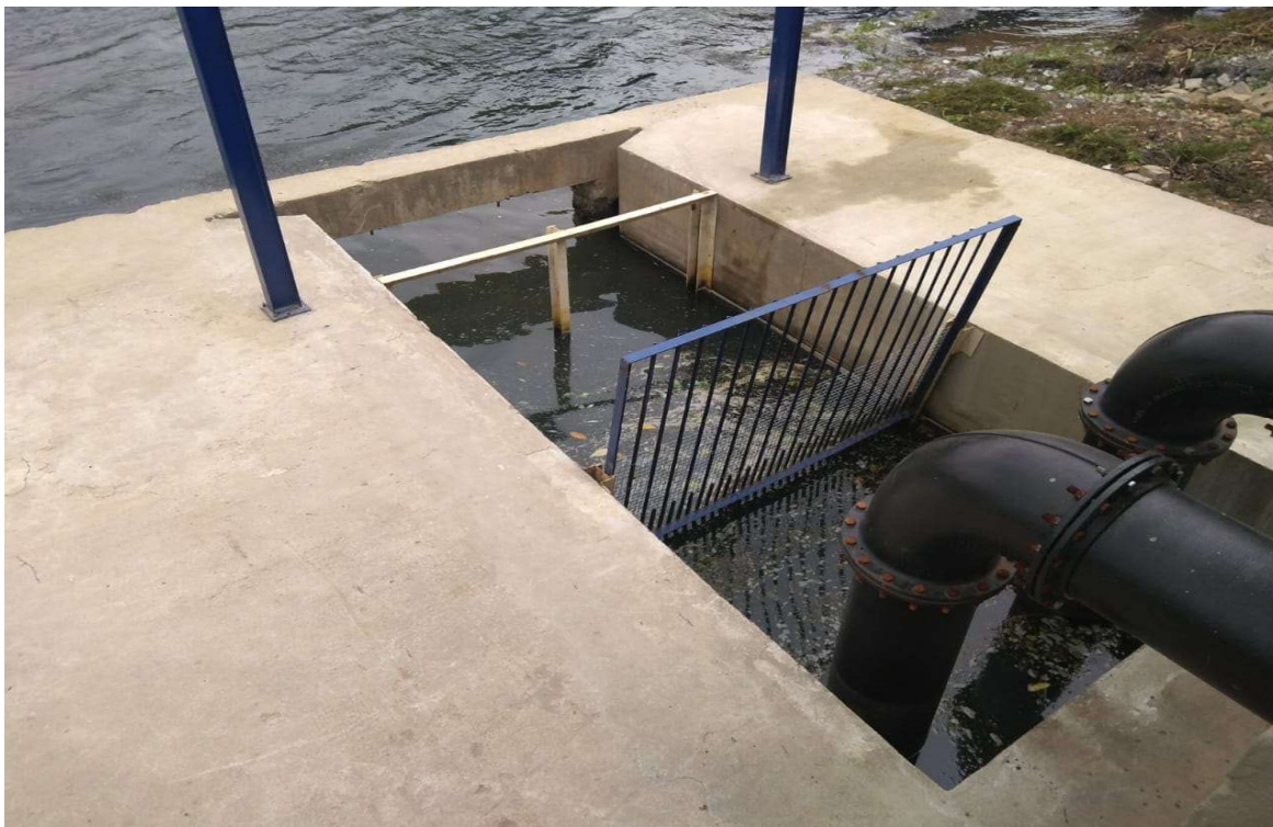
Fotografia 2 – Gradeamento para sólidos grosseiros antes da sucção por válvulas de crivo.
