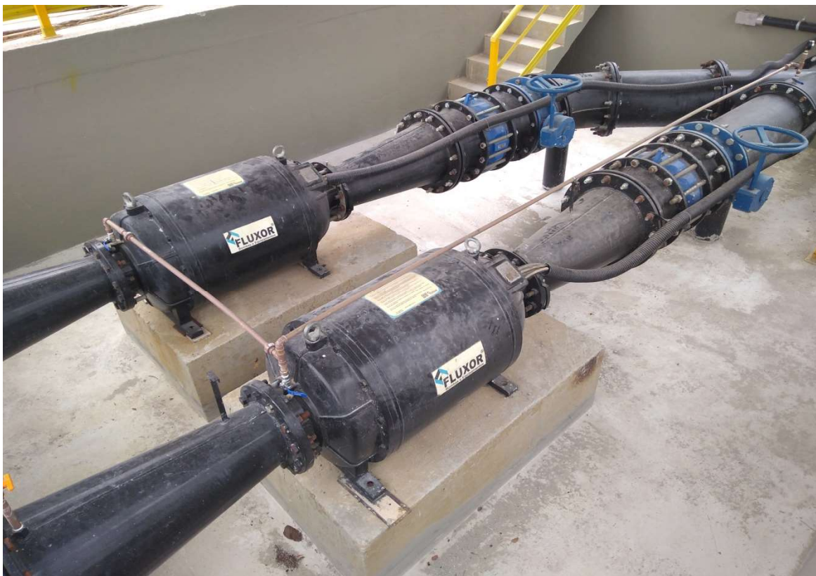
Fotografia 3 – Equipamentos motor-bomba
