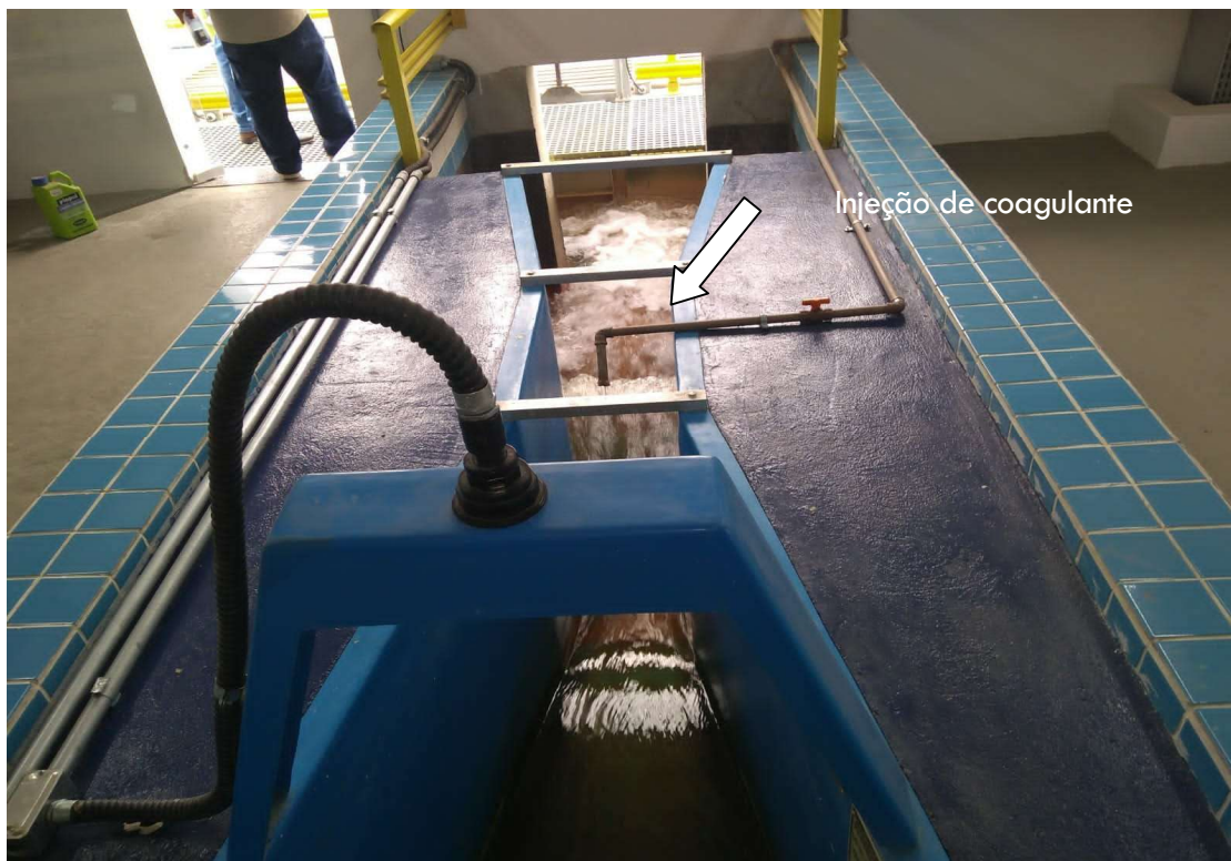
Fotografia 4 – Calha Parshall
