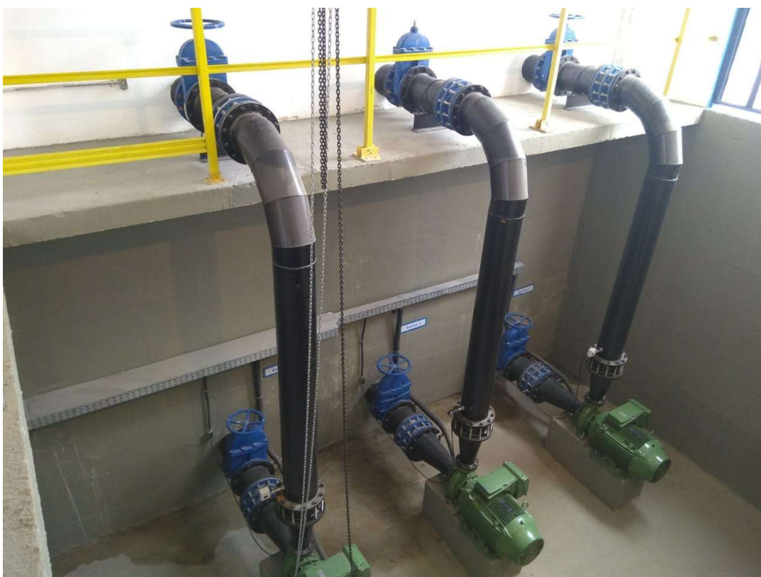
Fotografia 23 – Conjuntos Motor-Bomba
