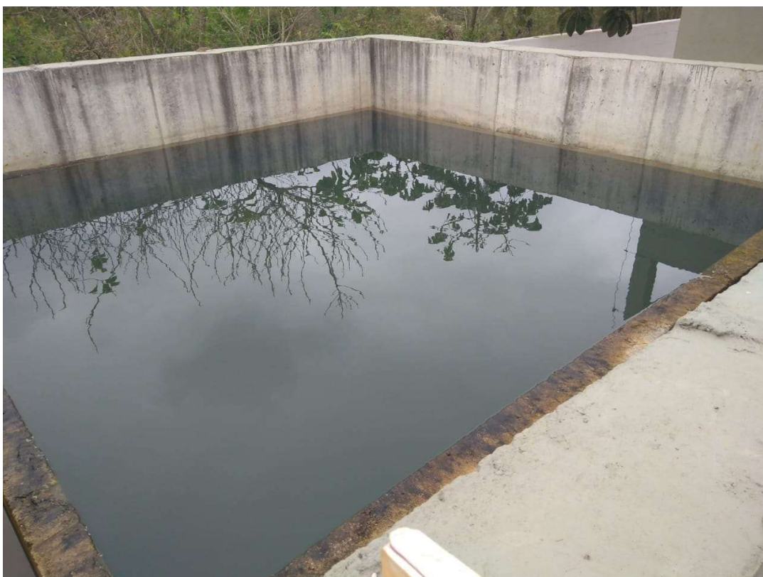
Fotografia 16 – Tanque de Decantação do Lodo Tratado
