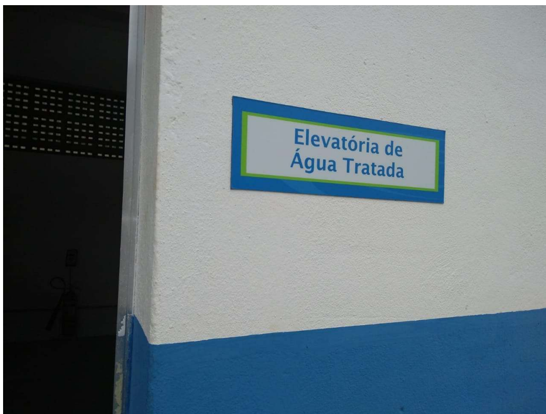
Fotografia 21 – Entrada da elevatória
