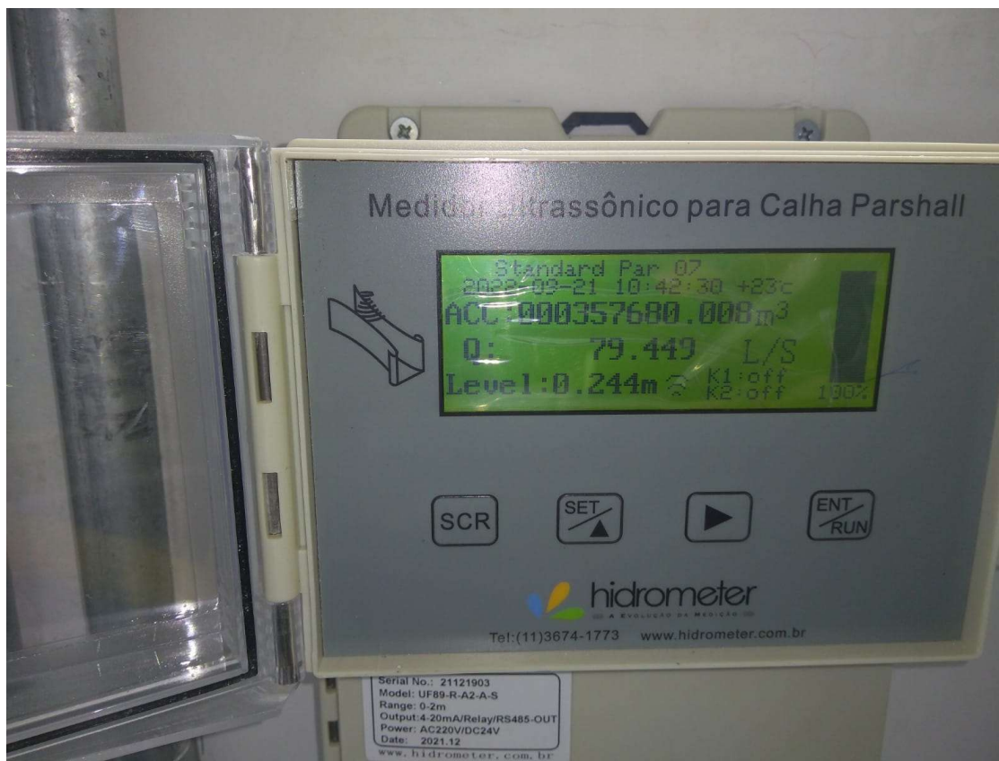
Fotografia 5 – Medidor ultrassônico de vazão
