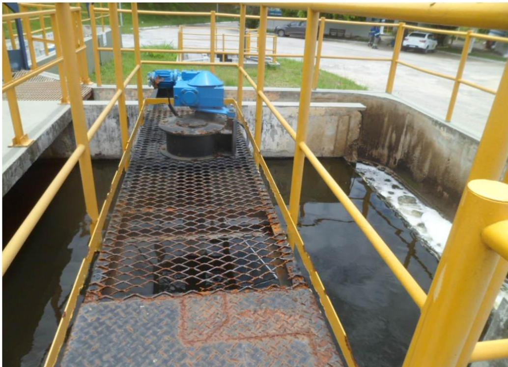
Foto 09 – Tanque Desarenador
