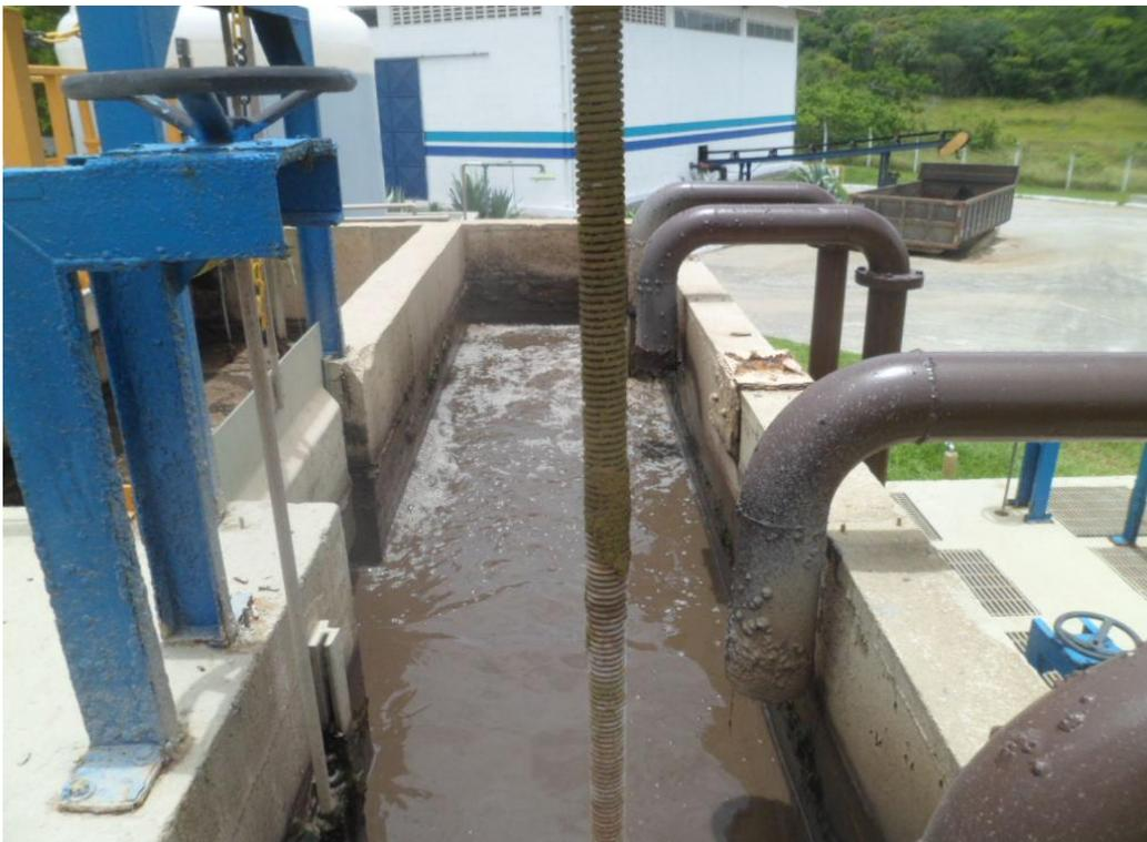
Foto 11 – Elevatória de Esgoto Bruto e Recirculado
