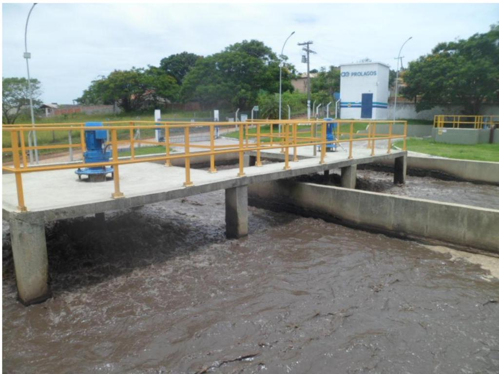
Foto 12 – Tanques de Aeração de Lodo Ativado
