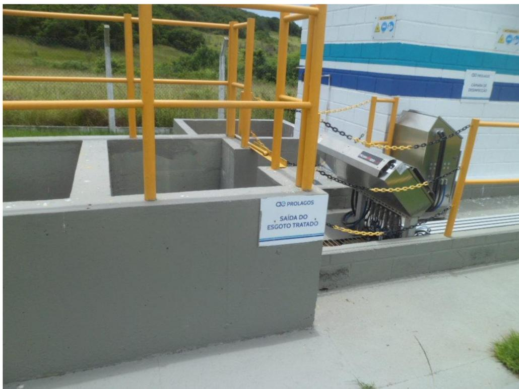
Foto 20 – Saída do Esgoto Tratado e Câmara UV
