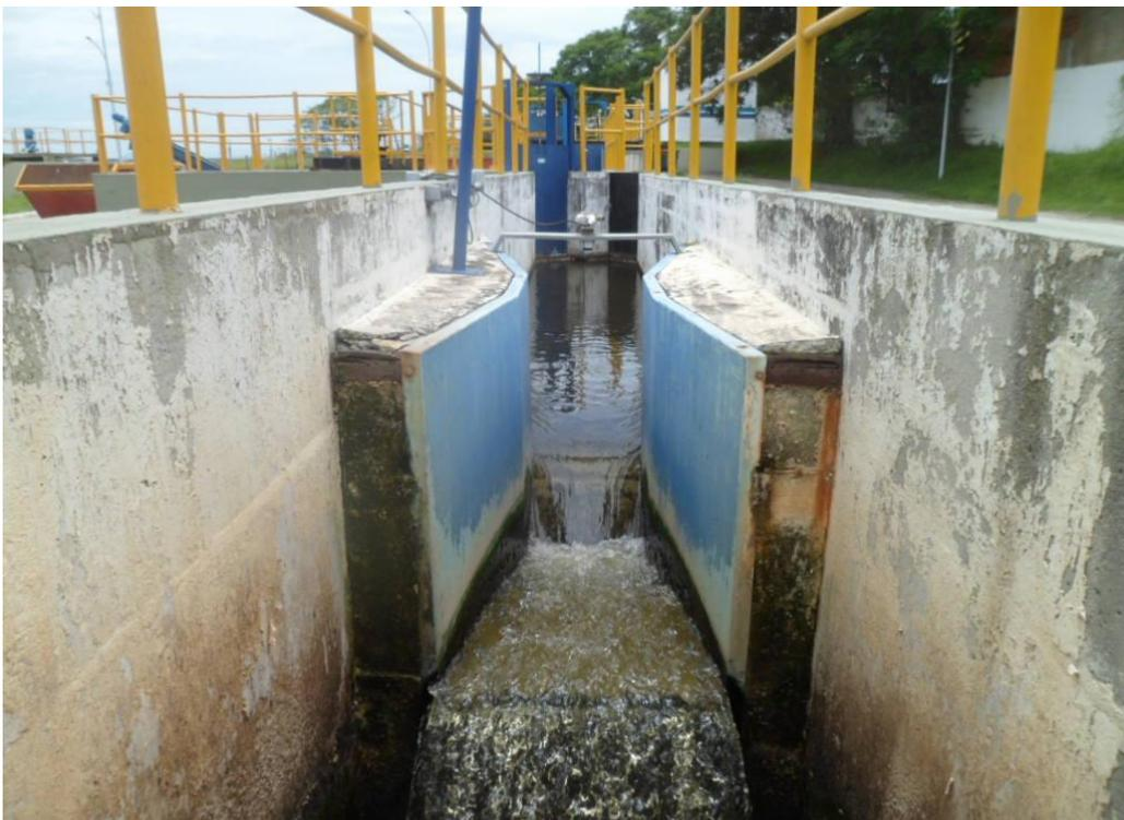
Foto 07 – Calha Parshall com Medidor de Vazão Ultrassônico
