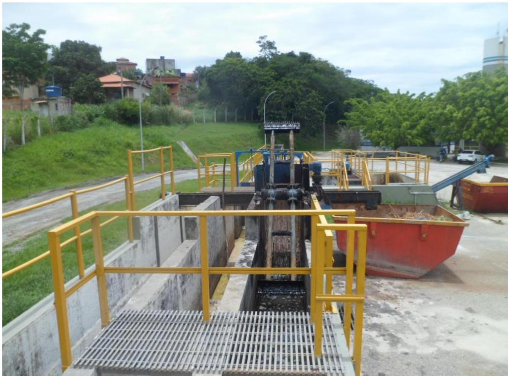
Foto 05 – Gradeamento para retenção de resíduos sólidos com pás mecânicas
