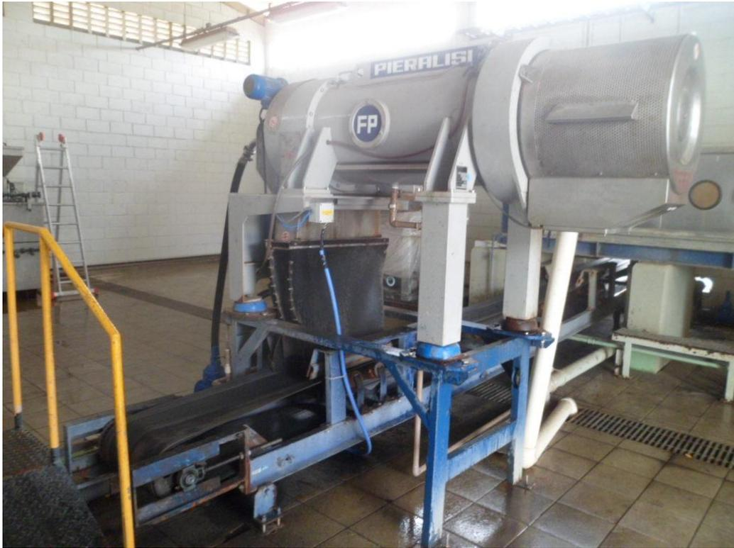
Foto 18 – Centrifuga Desidratação do Lodo
