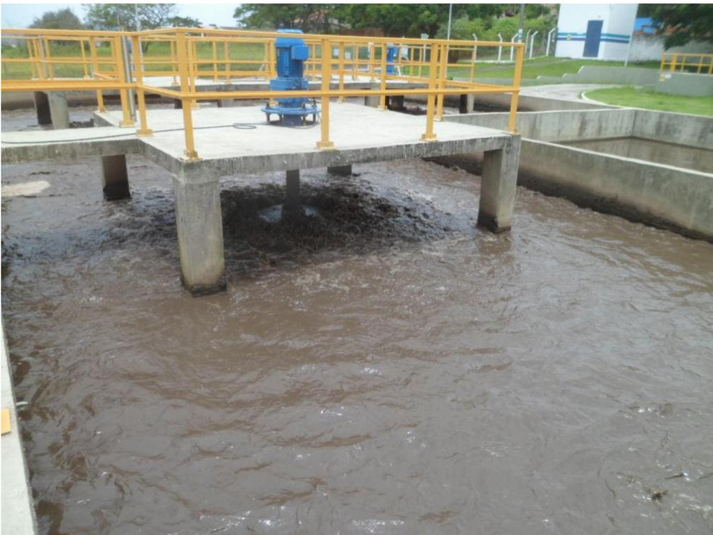
Foto 13 – Tanques com 04 (quatro) Aeradores Fixos
