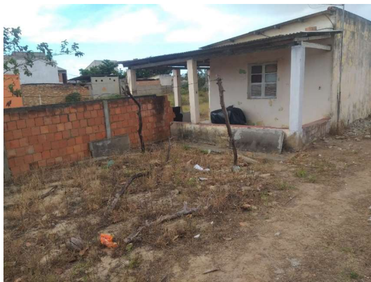
FOTO 7 - CONSTRUÇÃO SITUADA NOS N°s 10 e 08
