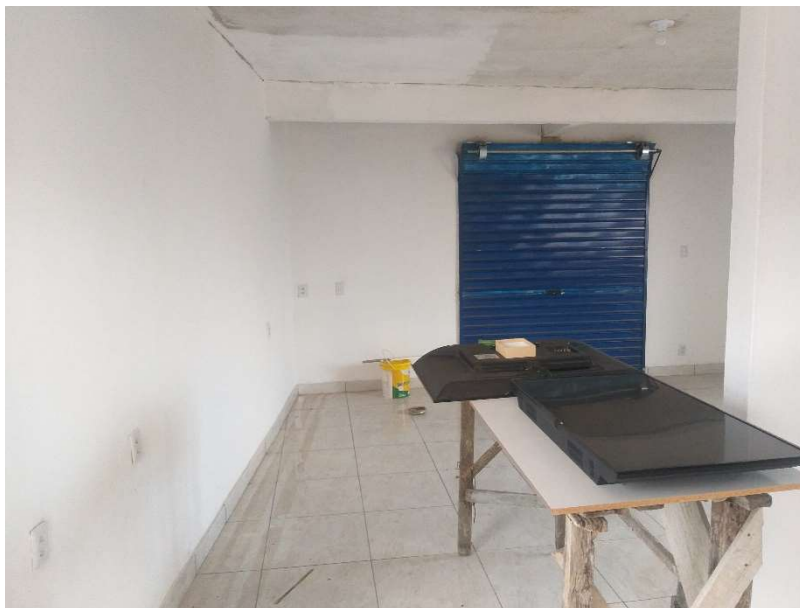
FOTO 20 –INTERIOR DA TERCEIRA EDIFICAÇÃO (VISTA DOS FUNDOS)
