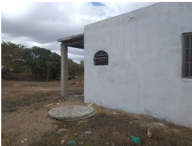
FOTO 13 – FACHADA OPOSTA À FACHADA DA FOTO 11
