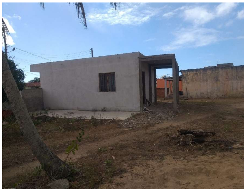
FOTO 11- TERCEIRA EDIFICAÇÃO (ALVO) – VISTA DE DENTRO DO TERRENO
