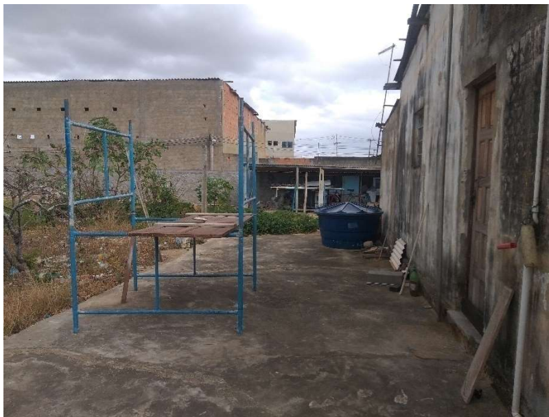
FOTO 6–FUNDOS EDIFICAÇÃO SITUADA N° 08
