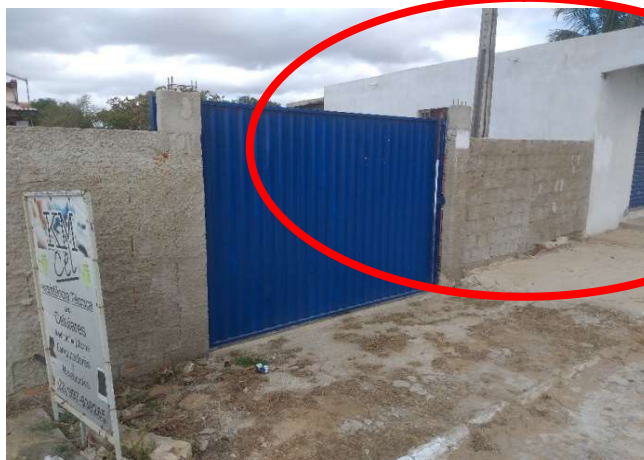
FOTO 10- TERCEIRA EDIFICAÇÃO À ESQUERDA DA IMAGEM
