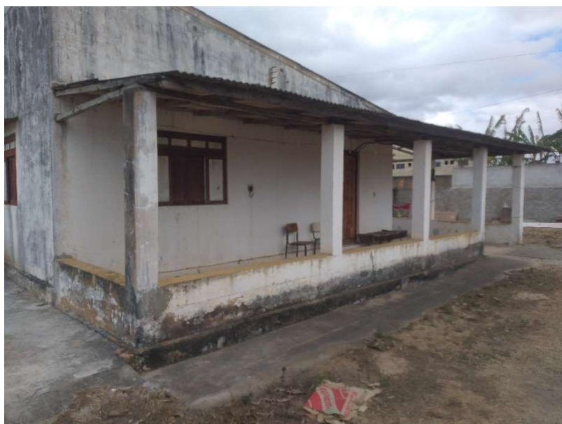
FOTO 3- EDIFICAÇÃO TIPO RESIDENCIAL ERGUIDA NO Nº08
