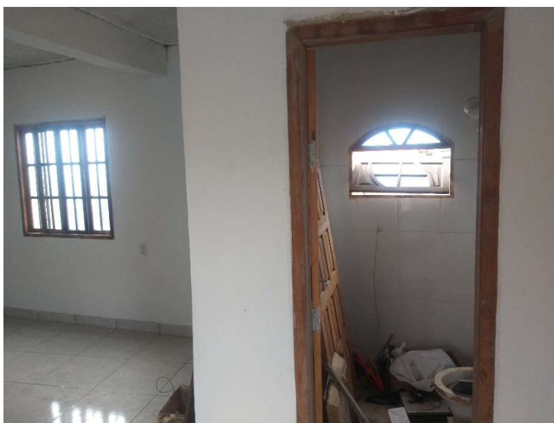
FOTO 17- EDIFICAÇÃO POSSUI SOMENTE BANHEIRO ALÉM DO COMODO PRINCIPAL
